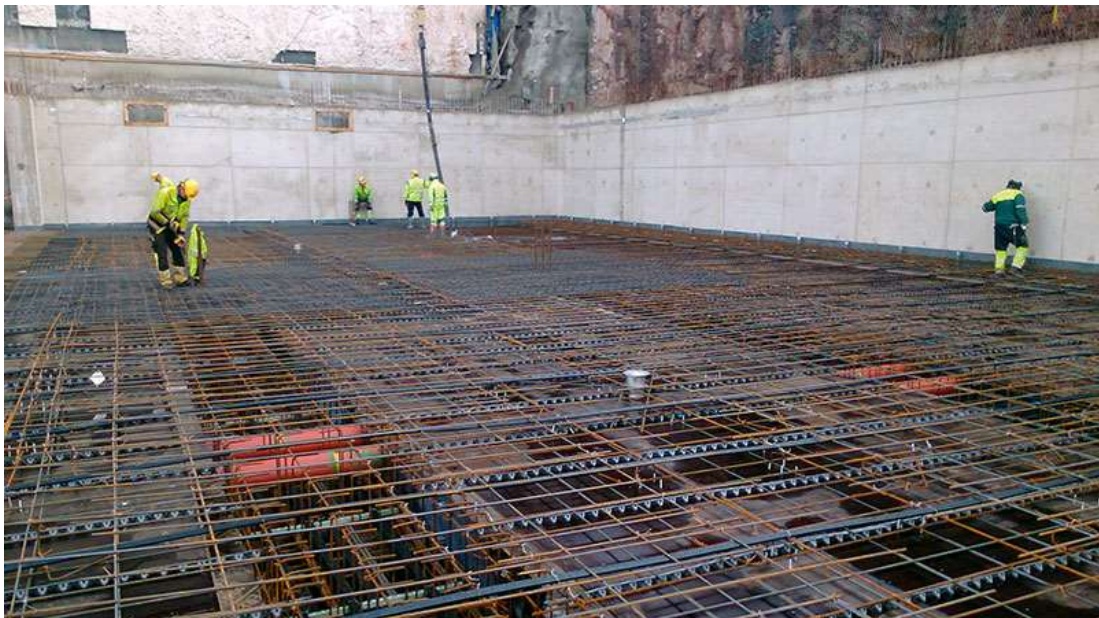
Kuva 5. X- ja Y-suuntaisesti sidotut raudoitteet (Muottikolmio www-sivut. 2014. Matinkylän metrokeskus holvi raudoitus)
