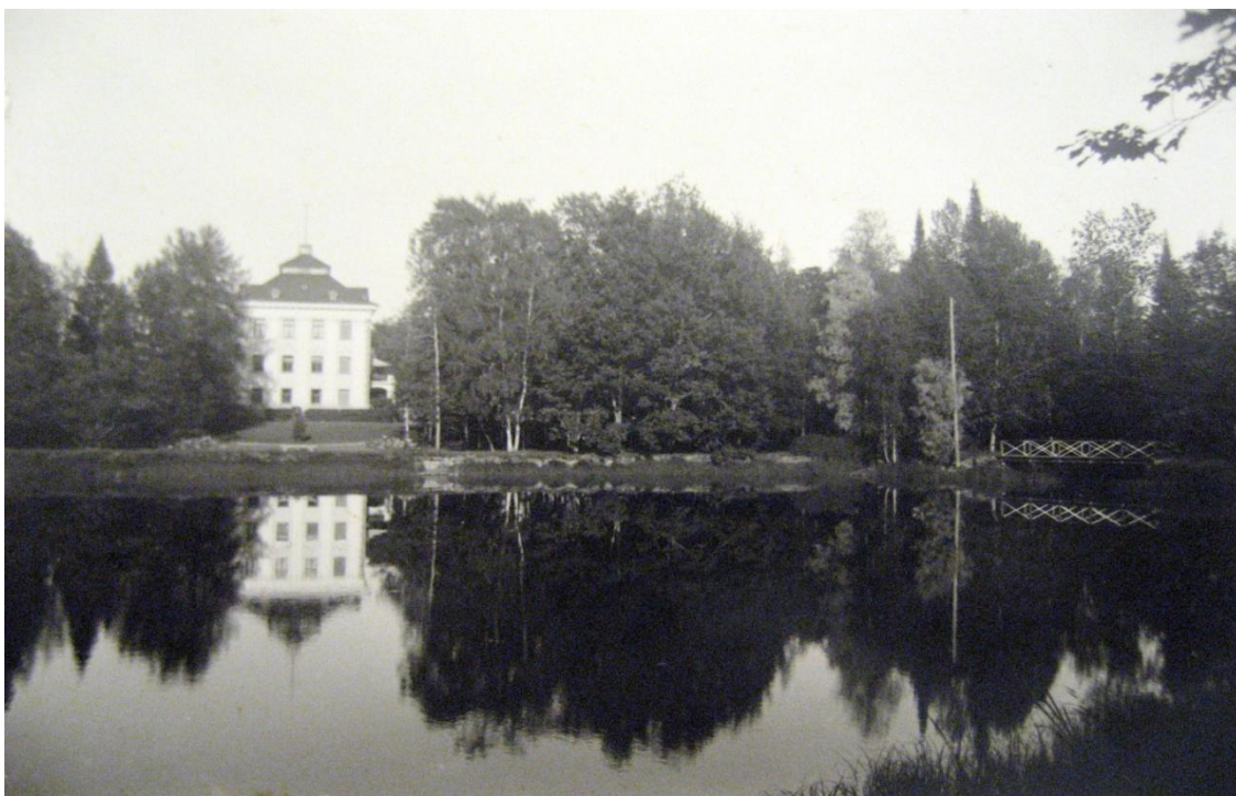
Figur 25: Vyn från väst mot corps de logiet, 1936-39. Den västra fasaden återspeglas vackert i dammen. Källa: Svenska litteratursällskapet i Finland, Helsingfors. Sarvlax bildarkiv.
