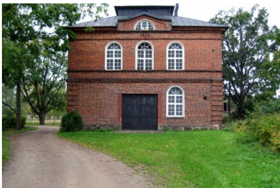
Figur 6: Magasinsbyggnaden på östra sidan av den norra infarten. Foto: Jenna Andersson, september 2011.
