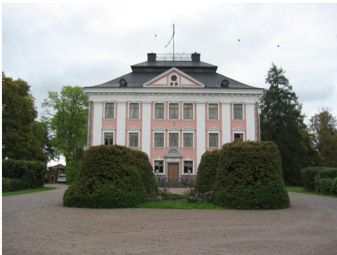
Figur 28: Corps de logiets norra fasad. På bilden kan man även se de stora tujorna och vattenelementet. Foto Jenna Andersson, september 2011.
