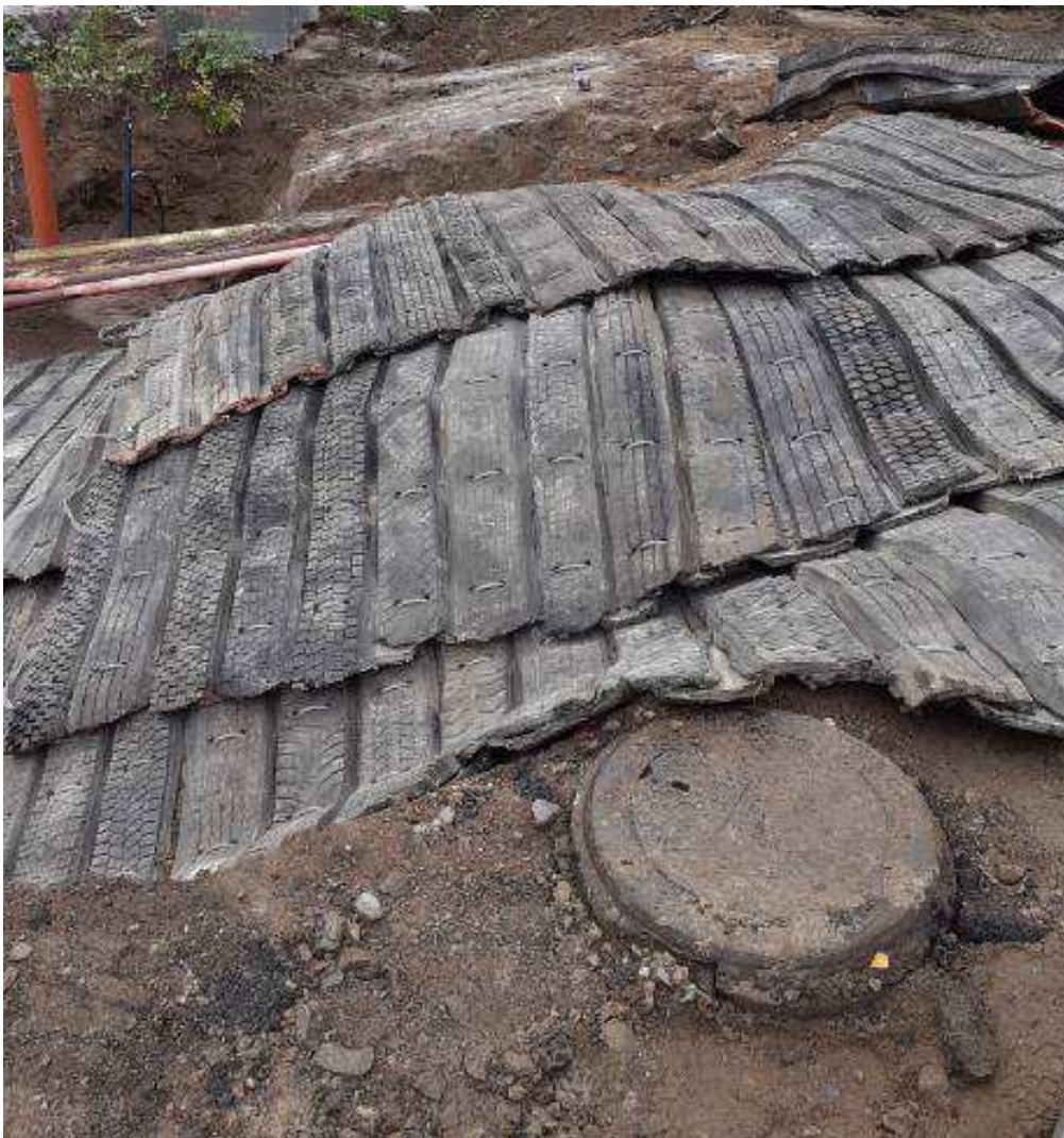
Kuva 6. Räjäytysmattojen riittävä käyttö.
