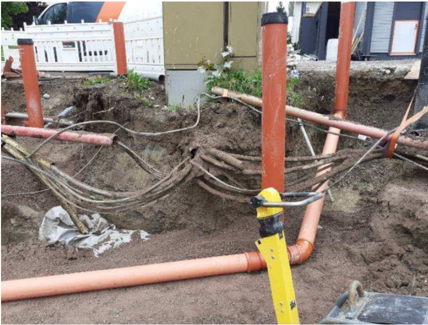
Kuva 9. Olemassa olevia kaapeleita auki kaivettuna.
