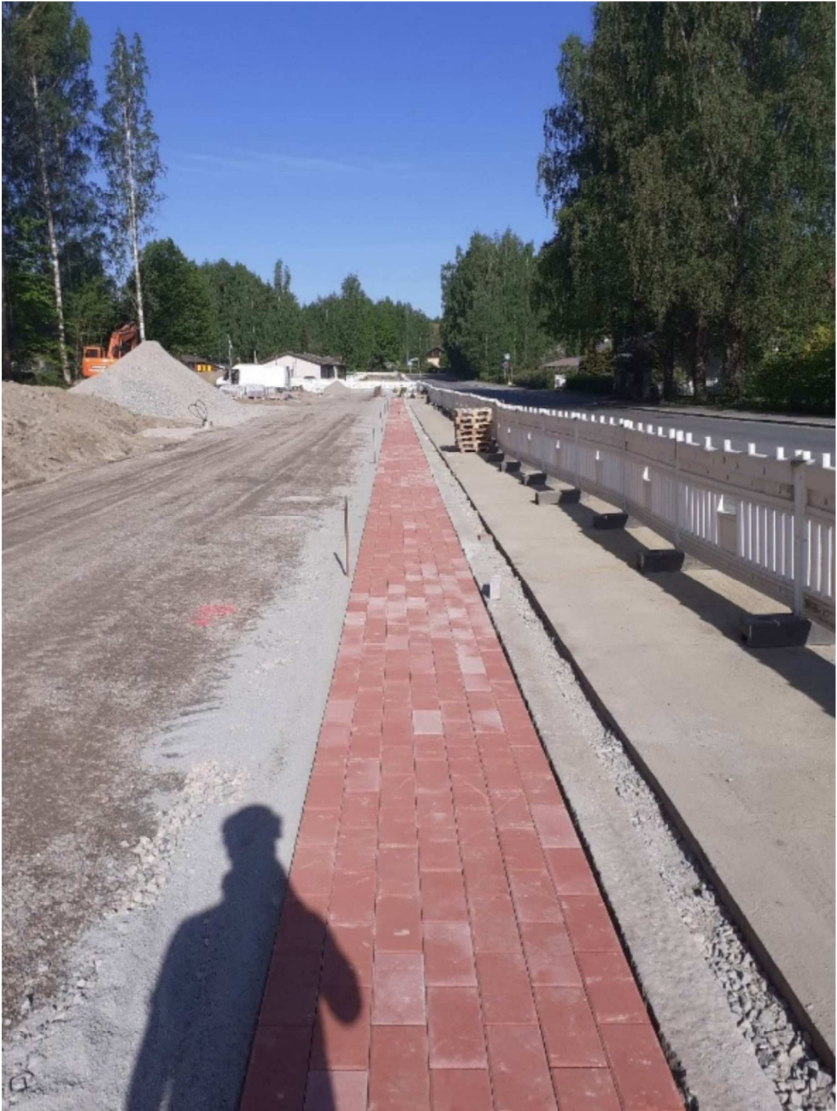
Kuva 12. Kivetystyö-alue eristettynä muusta liikenteestä.
