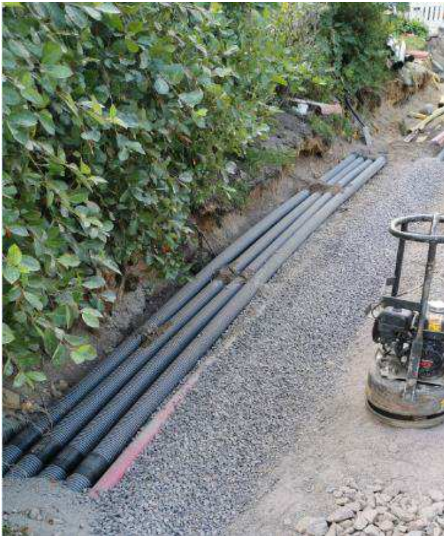
Kuva 10. Uutta kaapeliputkitusta.
