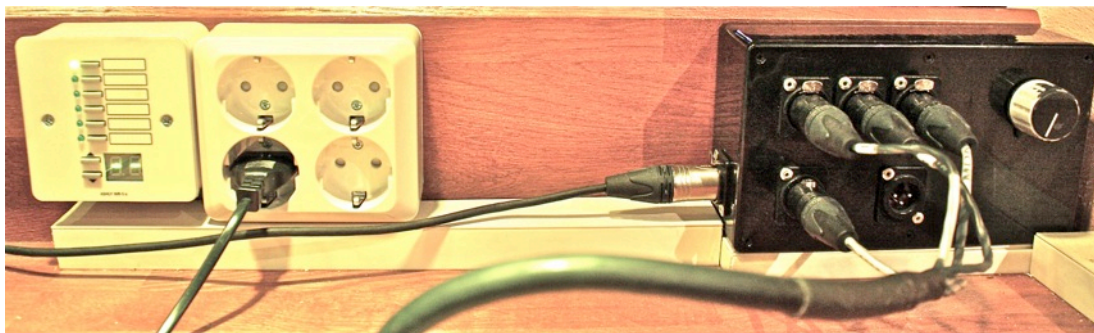
Kuva 4. Vasemmalla Ashleyn WR5 Wall kaukosäädin. Oikealla äänen kytkentärasia.
