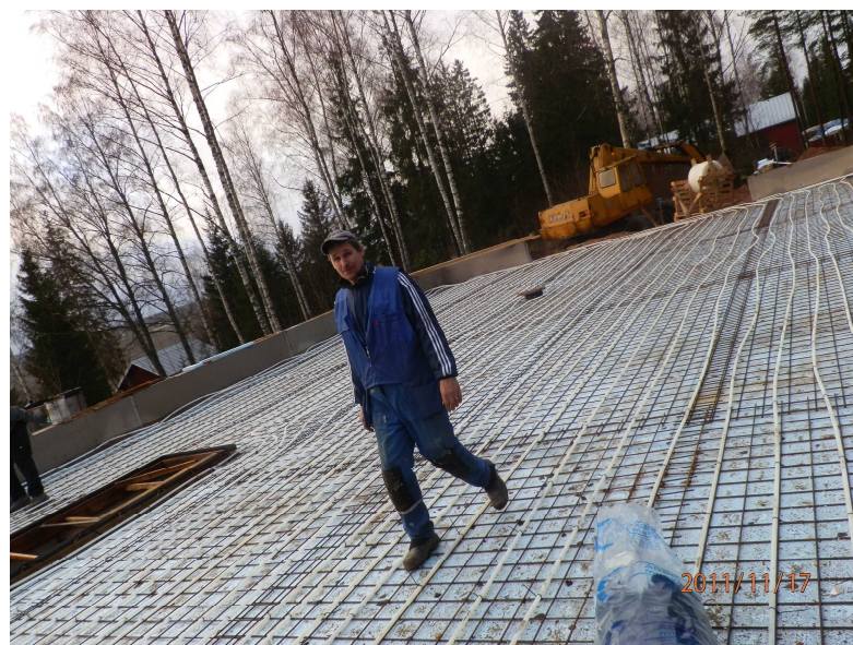
Kuva 9 Konehallin lattia ennen valua
