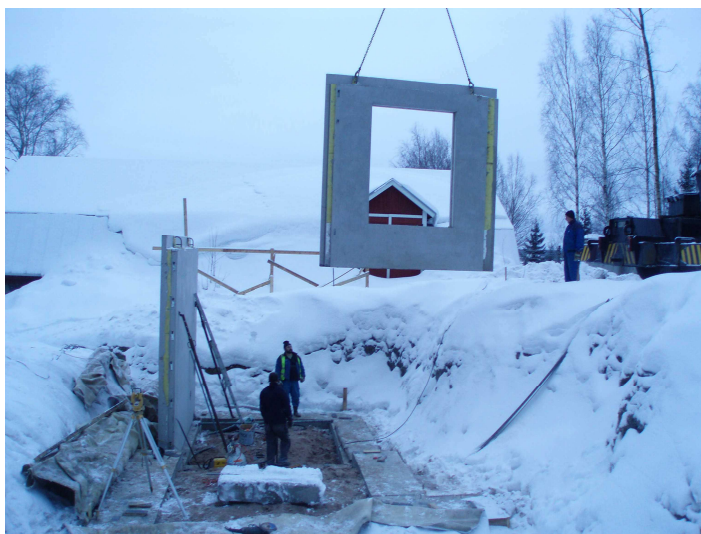
Kuva 4 Pannuhuoneen betonielementtien pystytys
