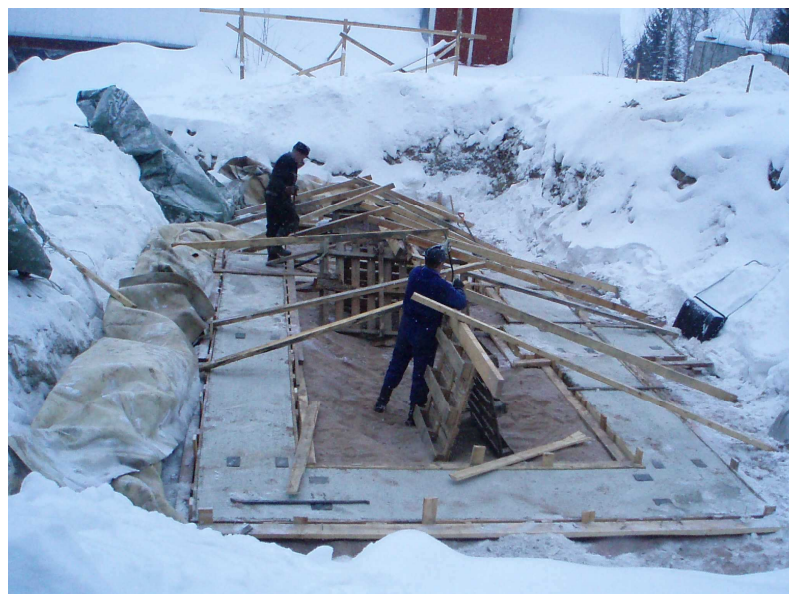
Kuva 3 Pannuhuoneen anturateltan purku
