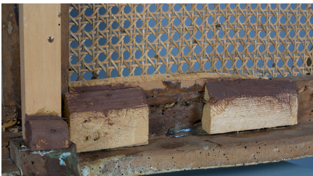
Kuva 46. Havupuiset tukipuulisäykset takasarjassa.
