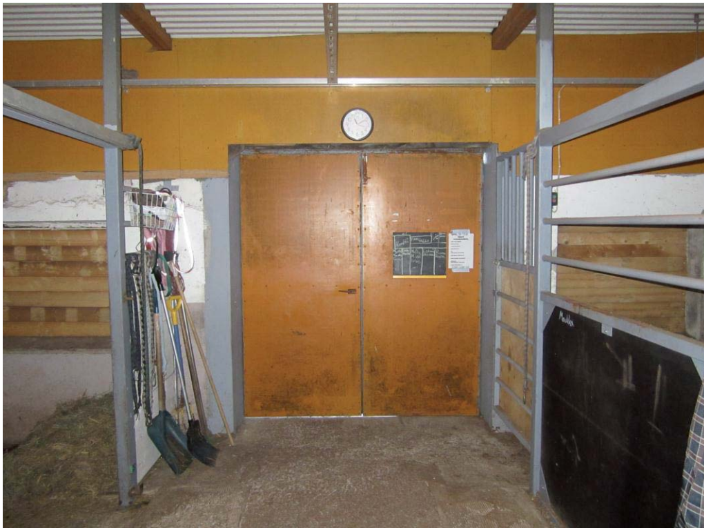
Kuva 2. Katonkorotus. Kuvassa näkyy kuinka matala vanha navetta oli.
