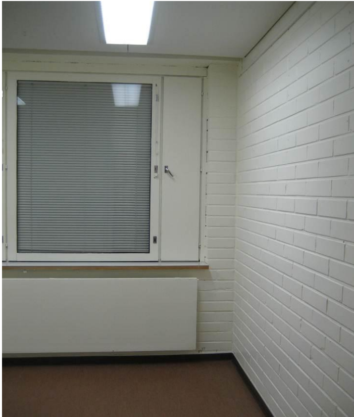
Huone maalattuna ja muovimatto asennettuna.
