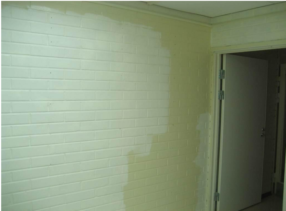
Huone maalauksen aikana.
