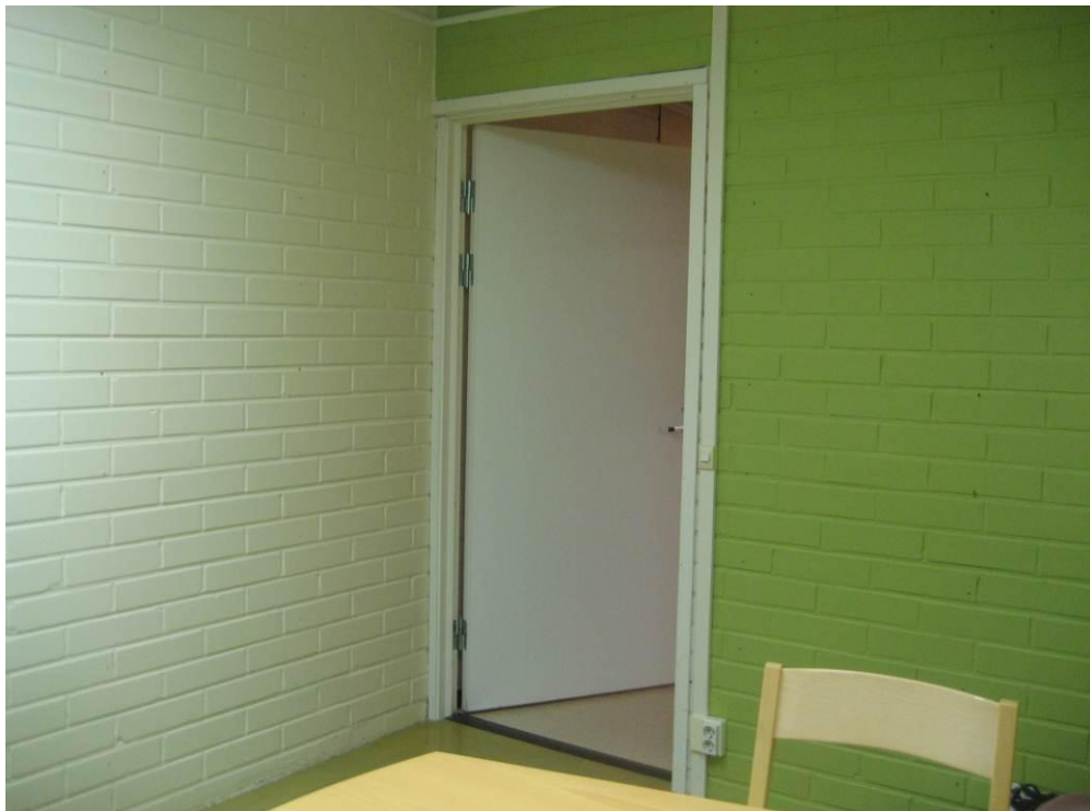
Huone ennen maalausta.
