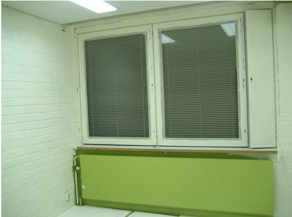
Huone maalauksen aikana.
