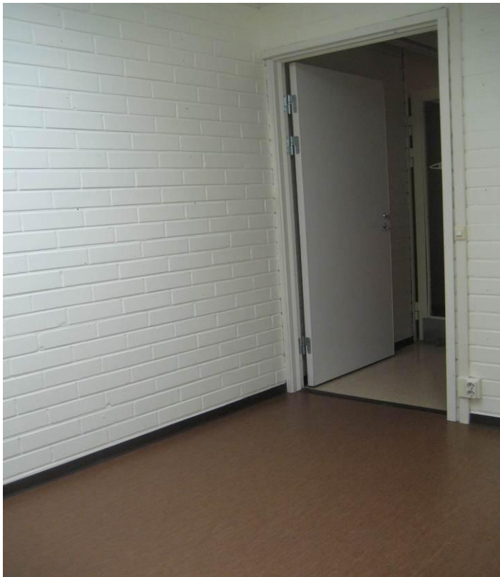
Huone maalattuna ja muovimatto asennettuna.
