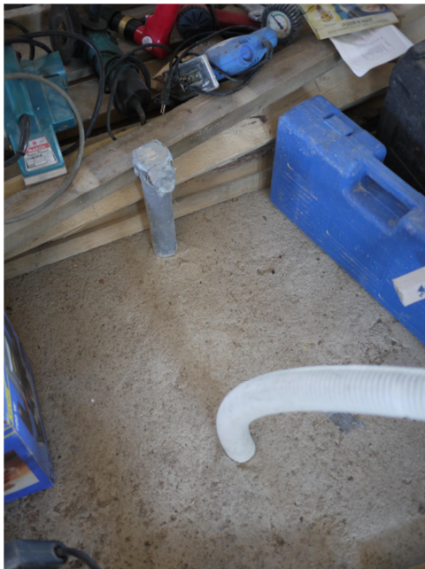
Kuva 24. Keittiön viemäriputken ja käyttöveden liittymäkohta.
