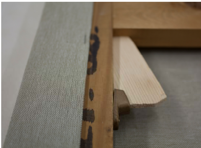
Kuva 40. Tukipuun kiilojen tilalle valmistettiin uudet kiilat, jotka tuettiin muovisin kiilatuin.
