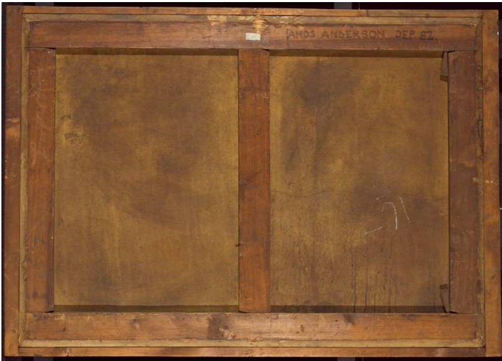
Kuva 18. Maalaus takaa ennen konservointia. Kuvassa näkyvät kiilakehyksen rakenne ja jäljellä olevat kiilat.
