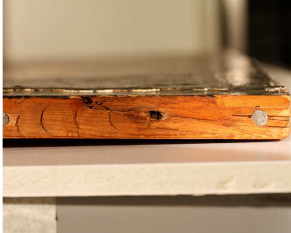
Kuva 34. Lisälistoihin on lisätty uusia lan- kanauloja, jotka näkyvät kuvassa vasemmalla ja oikealla. Keskellä oleva vanha naula on uponnut syvälle puuhun. Uusien naulojen vasaroinnista on jäänyt puuhun pyöreitä jälkiä.
