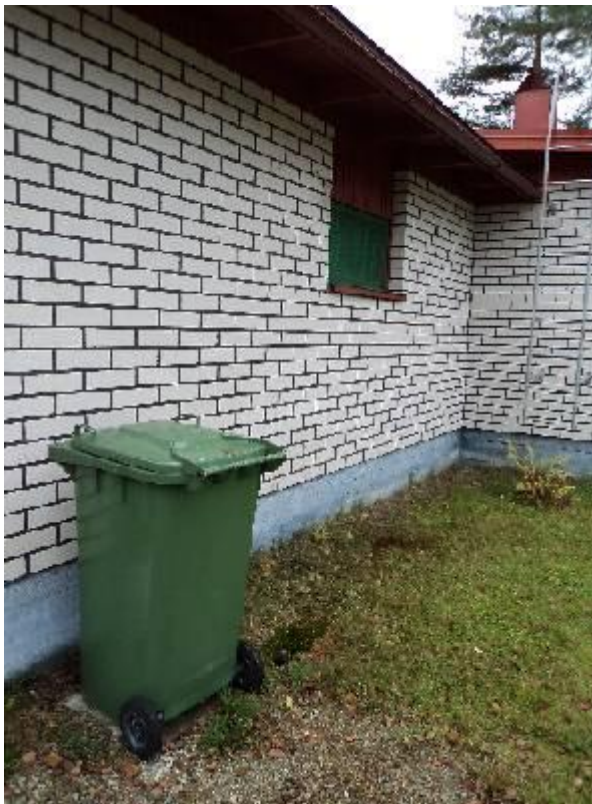
Kuva 7. Roska-astia sijoitettuna rakennuksen viereen.
