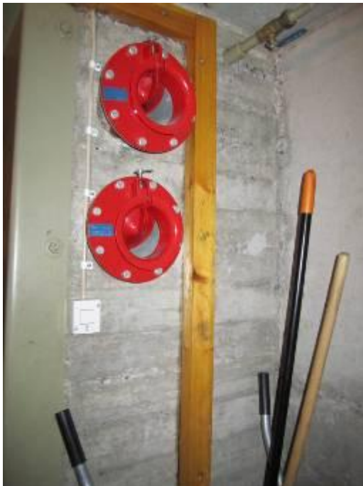
Kuva 20. Väärin asennettu valokatkaisija.
