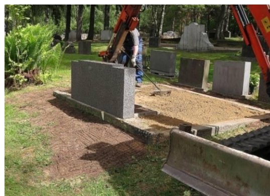
Kuva 58. Hiekkapintaista hautaa kunnostetaan. Etualalla paikattua nurmikkoa.
