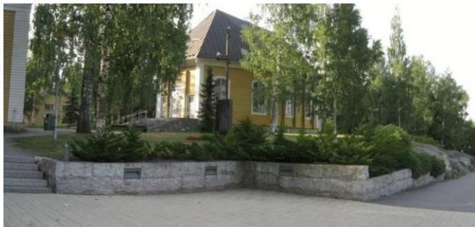
Kuva 47. Heinolan kirkon ja Kirkko puiston pääsisäänkäynti. Pensaita kastellaan tarvittaessa ison letkuvaunun avulla.
