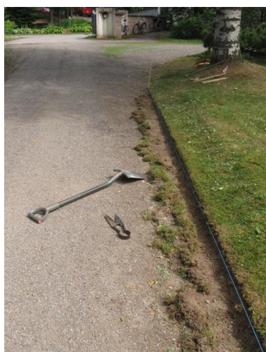
Kuva 16. Poistettava osa irrotetaan lapiolla.
