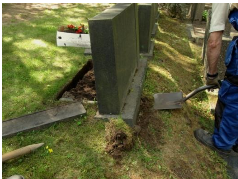
Kuva 53. Muistomerkin oikaisu. Rakenteiden alle tiivistetään maata juntalla sekä rautakangella.
