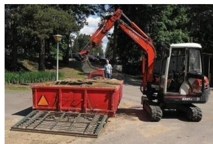
Kuva 52. Ylijäämämaa tiivistetään vaihtolavalle siirtokuntoon.
