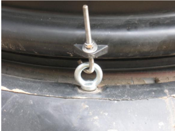
KUVA 3. Huoltokaivo lukitaan paikoilleen käyrillä kierretangoilla ja muttereilla
