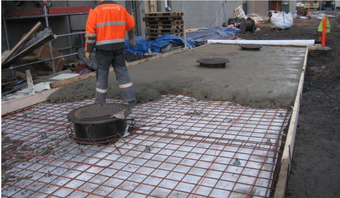
KUVA 4. Kuormantasauslaatan valu käynnissä
