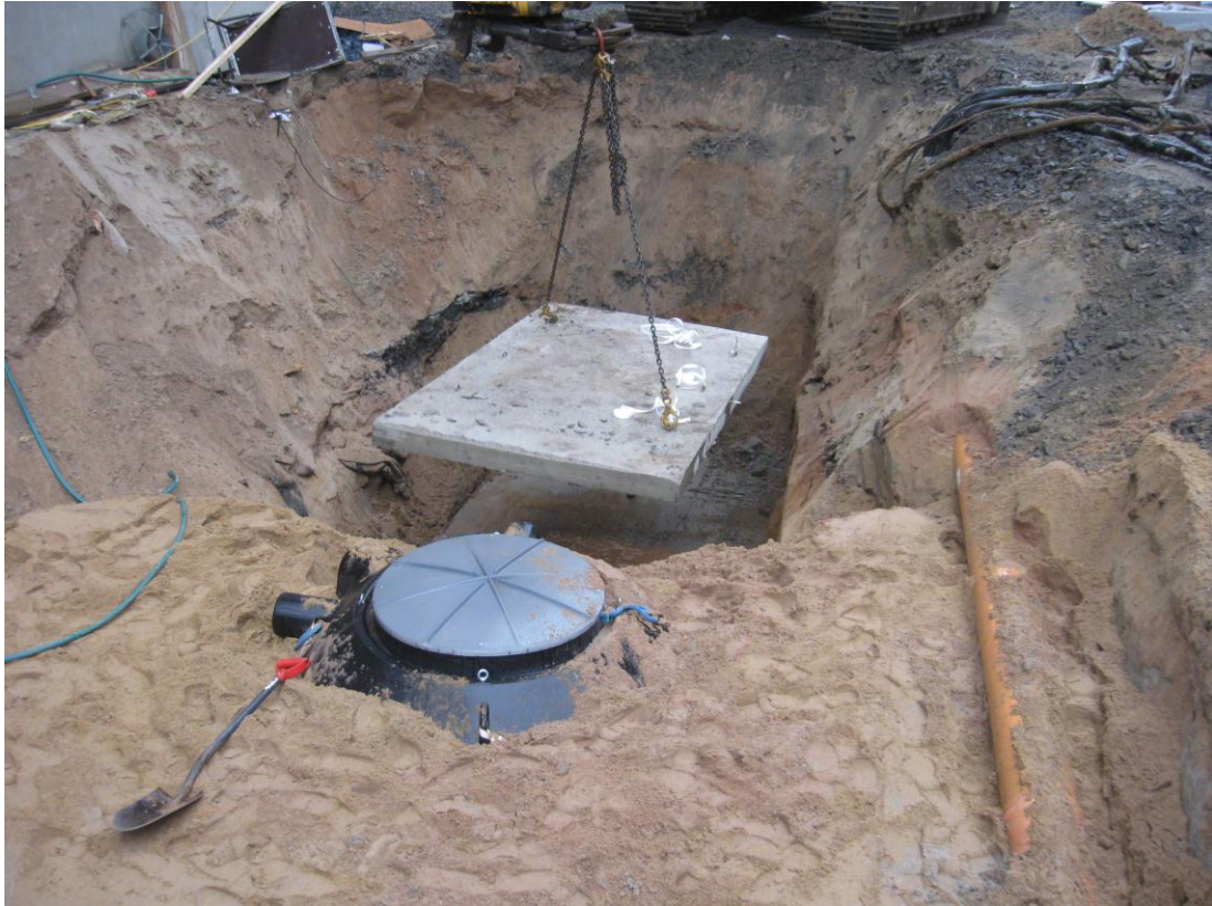
KUVA 6. Ankkurointilaatat nostettiin paikoilleen kaivinkoneella
