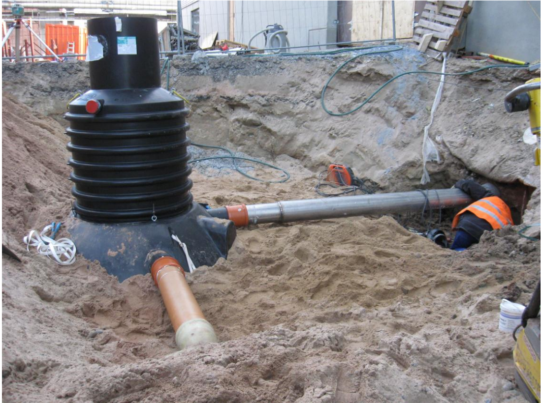
KUVA 2. Hiekan- ja lietteenerottimen tulo- ja lähtöyhteet sekä huoltokaivo asennettuna
