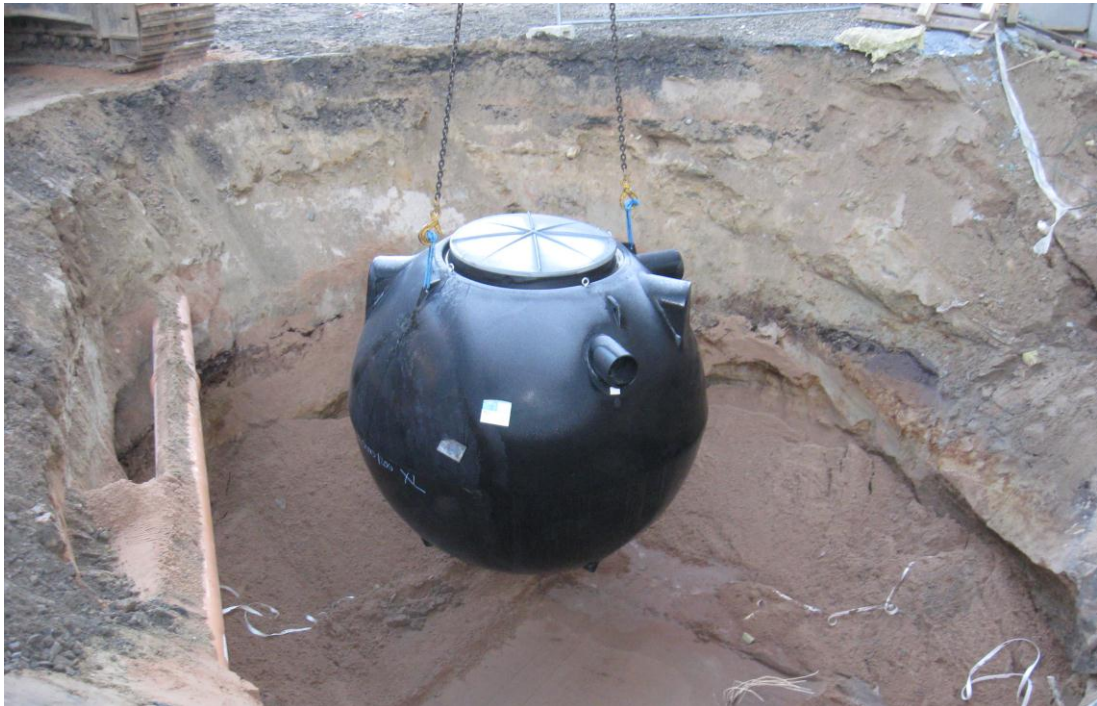
KUVA 1. Hiekan- ja lietteenerotin nostettiin asennuspaikalleen kaivinkoneella
