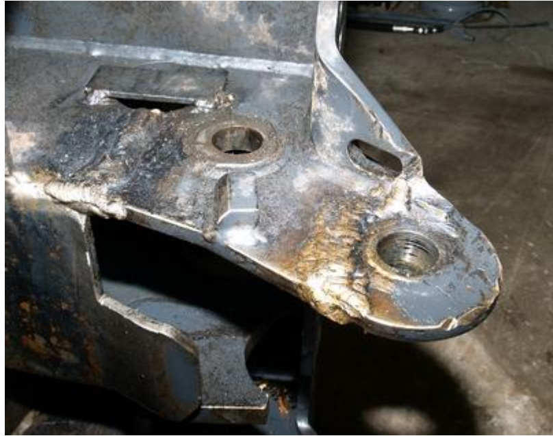
Kuva 16. Katkennut etukorvakelevy. (Kuva: Timo Ihalainen.)
