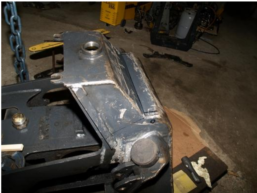
Kuva 23. Säiliöön merkittiin katkaisukohtat. (Kuva: Timo Ihalainen.)
