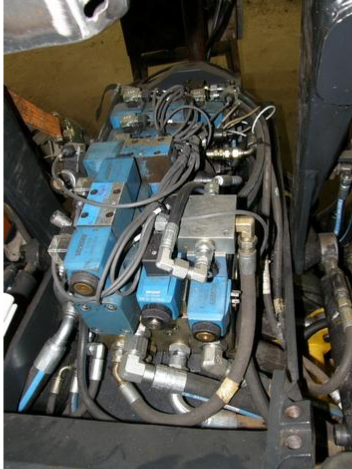
Kuva 50. Ketjusahan syötön säätöventtiili siirtyi venttiilipöydän toiselle puolelle, tilalle tuli joukkokäsittelylaitteen ohjaus. (Kuva: Timo Ihalainen.)
