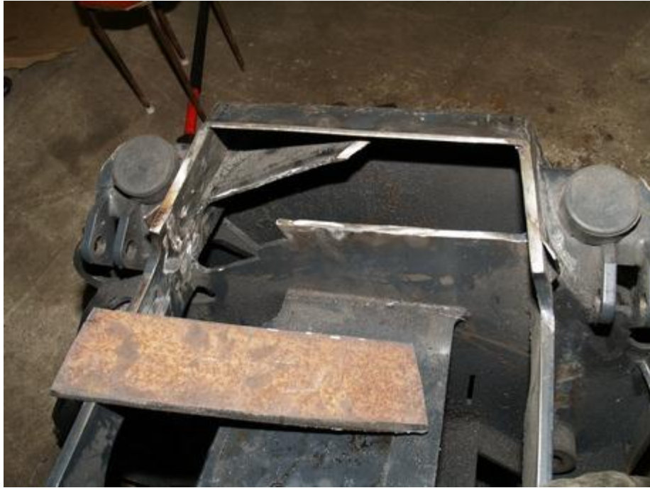
Kuva 26. Öljysäiliön jättämä aukko paikattiin sopivalla levyllä. (Kuva: Timo Ihalainen.)
