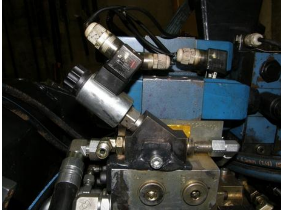
Kuva 43. Ketjun syötön säätöventtiili uudella paikallaan. (Kuva: Timo Ihalainen.)
