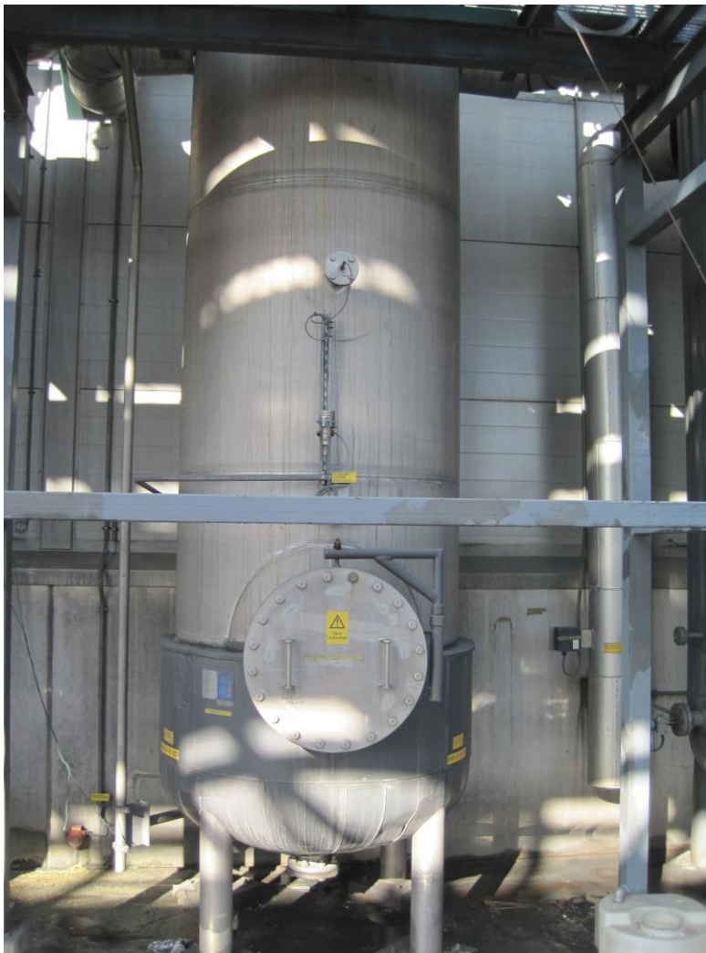
KUVA 12. Rikkivedyn paineentasaussäiliö
