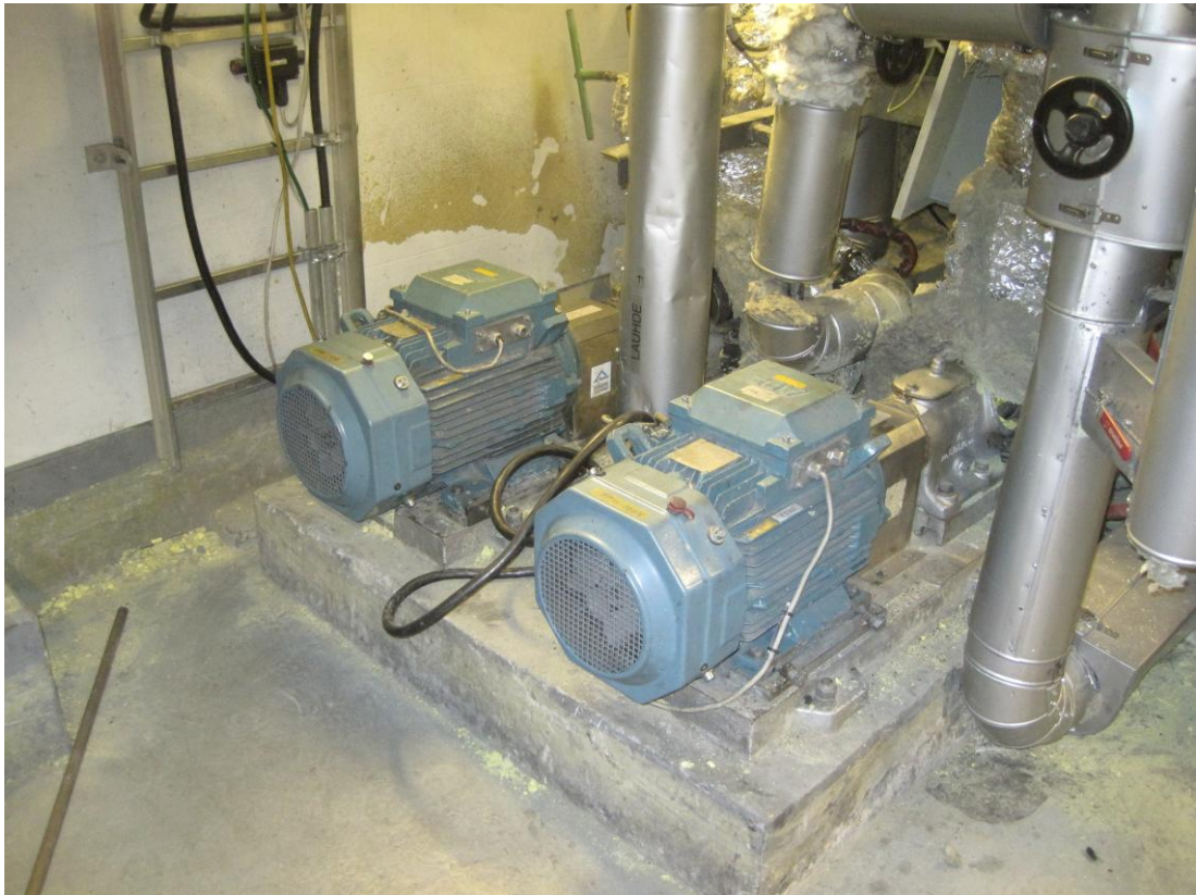
KUVA 7. Rikin syöttöpumput
