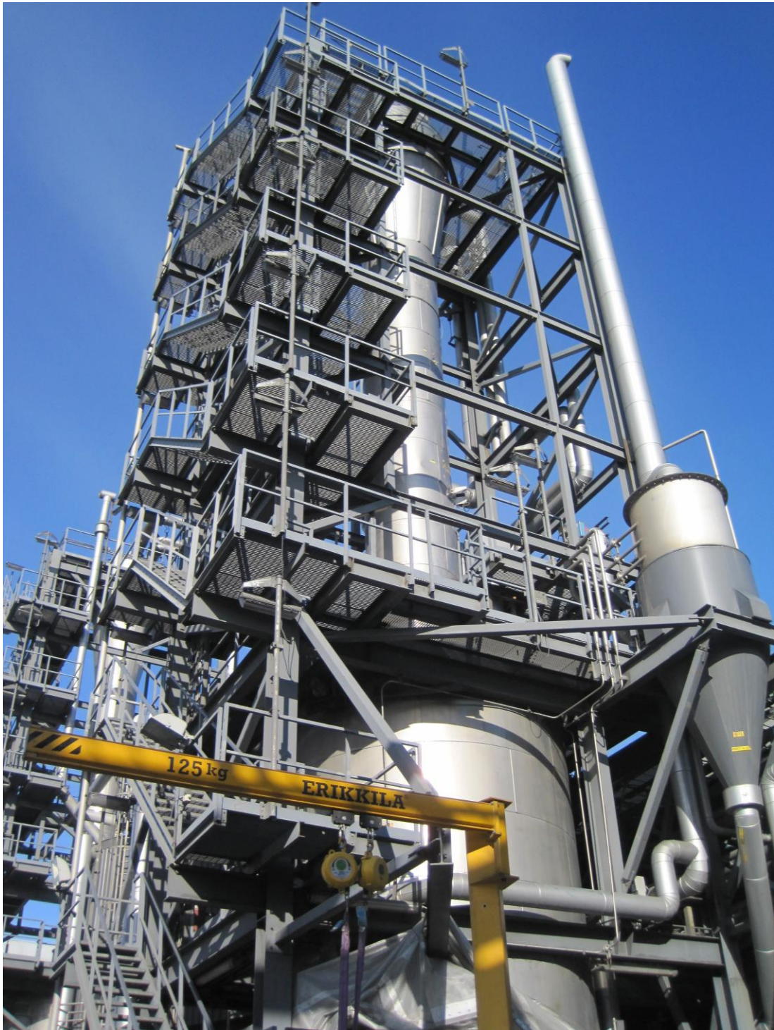
KUVA 10. Rikkivetykehitin
