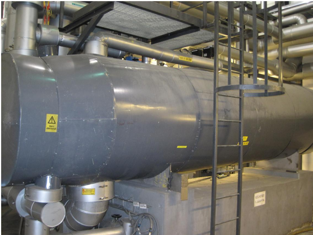
KUVA 11. Rikkivetyjäähdytin
