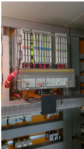
Kuva 14 Osa fosfatoinnin logiikoista
