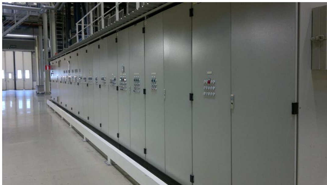
Kuva 13 Fosfatoinnin sähkökeskukset
