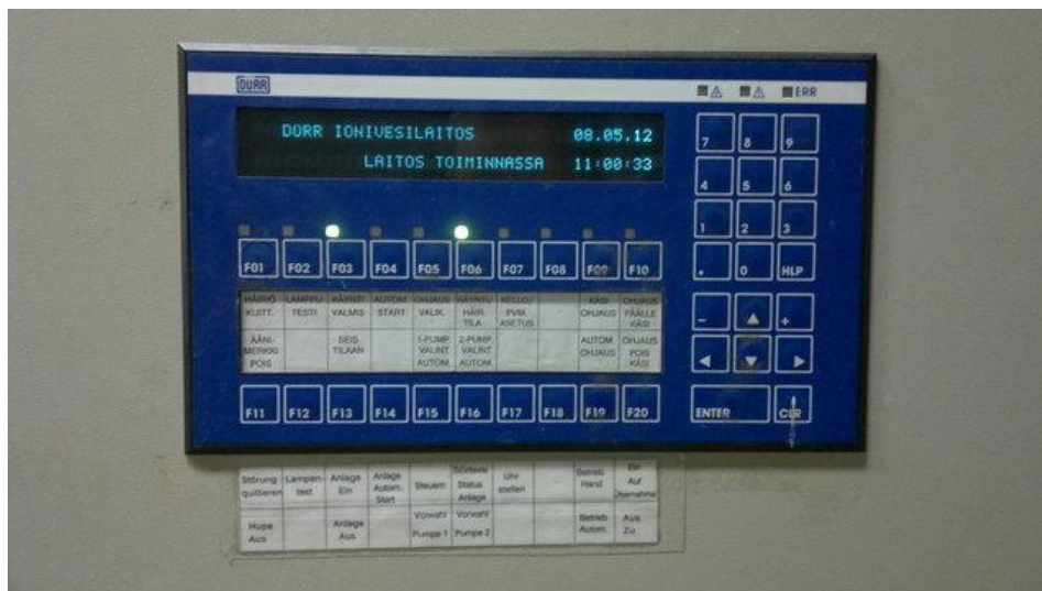
Kuva 24 Ionivesilaitoksen operointipaneeli
