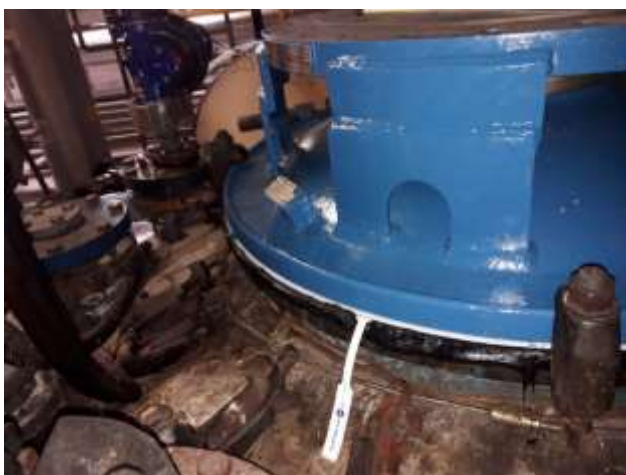
Kuva 15. Kansi paikallaan, massa jähmettymässä.
