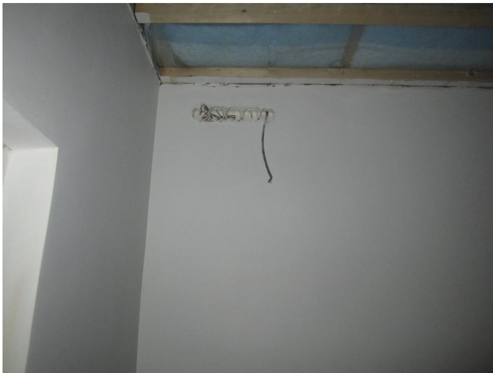
Kuva 2. Rasiat asennettu katon rajaan
