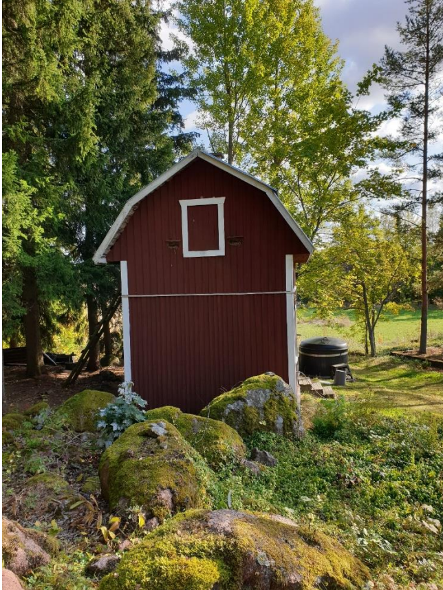
KUVAT 21.-23. Näkymiä pihapiiristä (Romppanen 2019)
