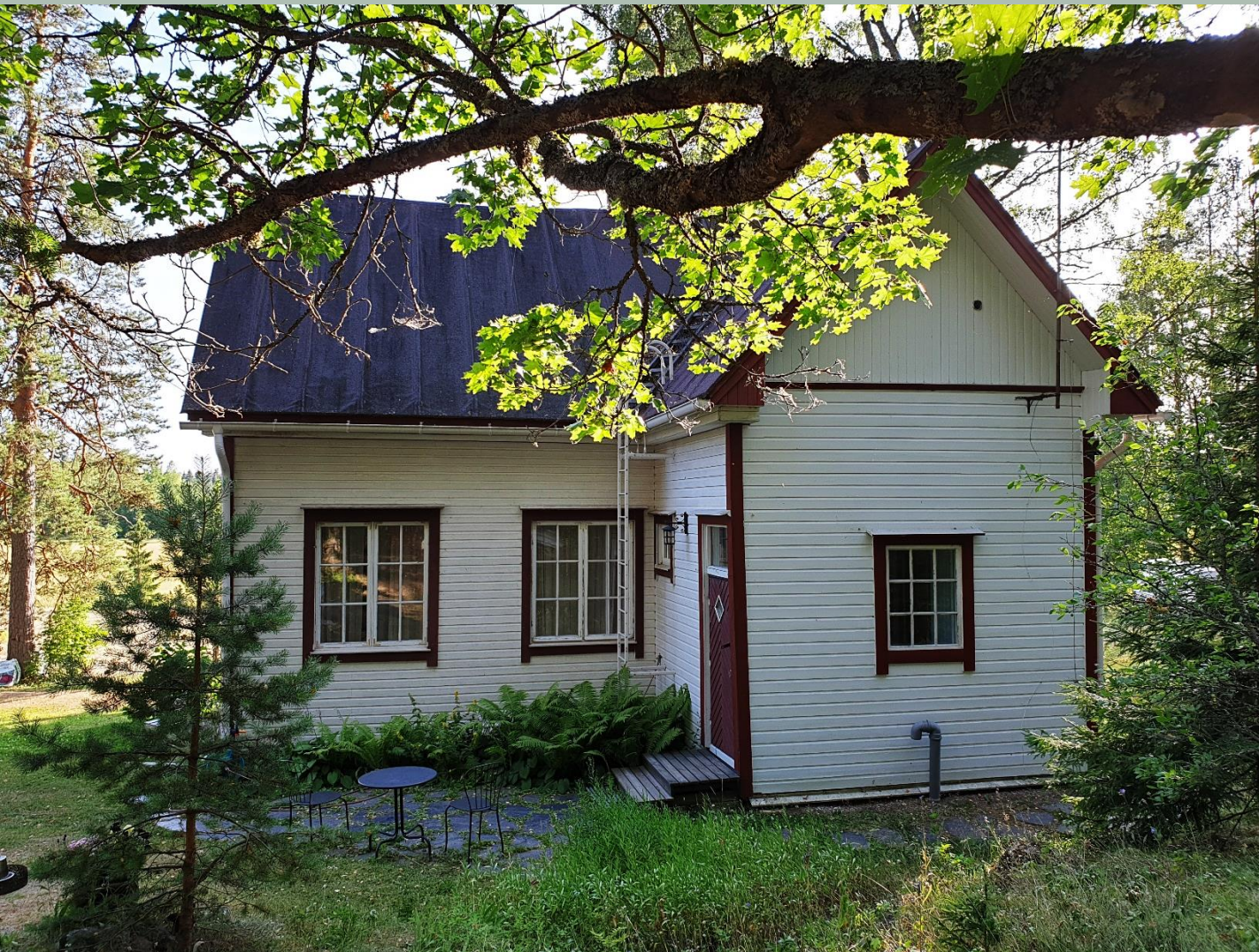
KUVA 126. Solbacka , julkisivu pohjoiseen (Romppanen 2019)
