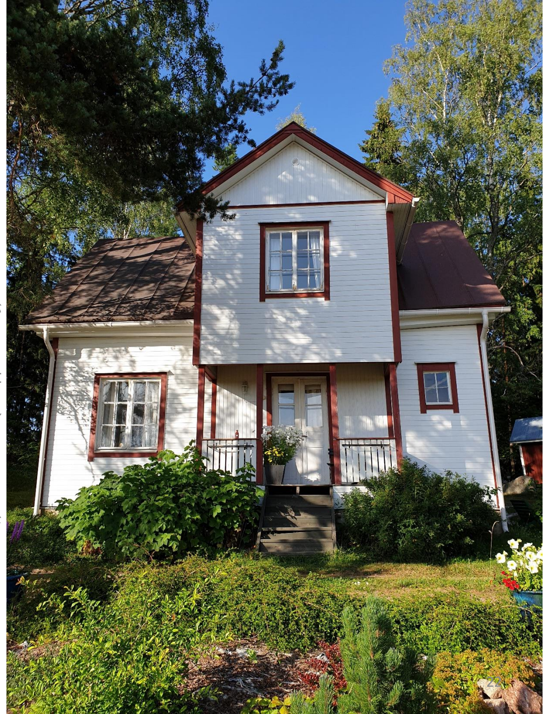
KUVA 16. Solbacka, julkisivu etelään (Romppanen 2019)
