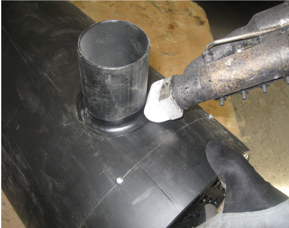
Kuva 2. Putken hitsaus käsiekstruuderilla. (Kuva: Mika Rahunen)
