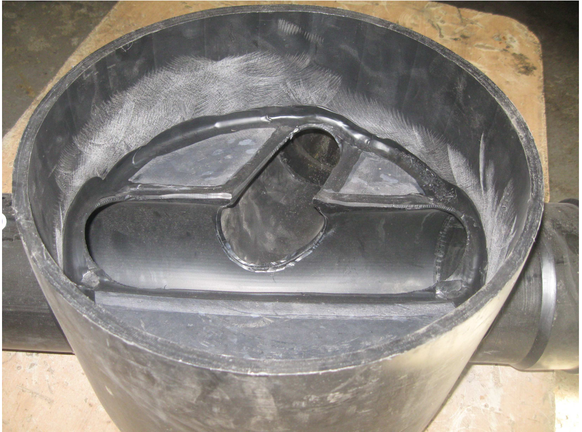
Kuva 10. Kahdesta putkesta rakennettu y-haara. (Kuva: Mika Rahunen)
