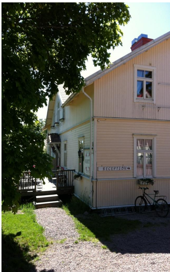
Kuva 13. Majatalo Martan julkisivu
