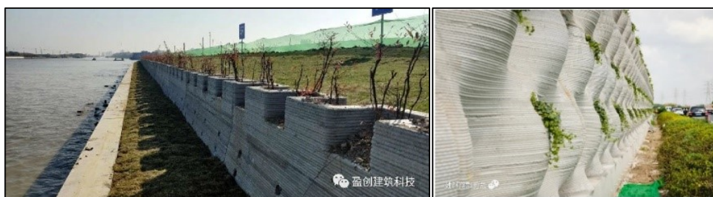
Kuva 12. Betonista 3D-tulostamalla valmistettu tulvamuuuri vasemmalla ja oikealla meluvalli (Winsun 2020).
