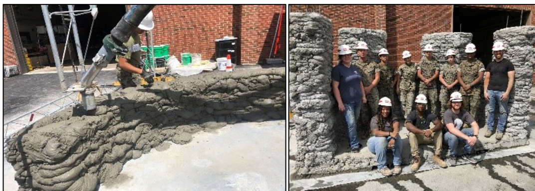
Kuva 46. Bunkkerin rakentaminen betonista 3D-tulostamalla (Sher 2019b).
