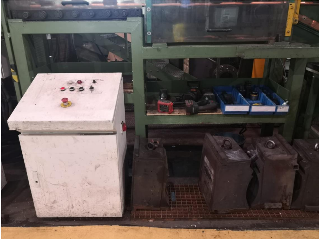
Kuva 23. Työkalutasot järjesteltiin ja taustalevyjen asentamisen jälkeen.
