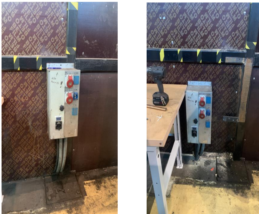
Kuva 29. Sähkökaappi ennen ja jälkeen siirron.
