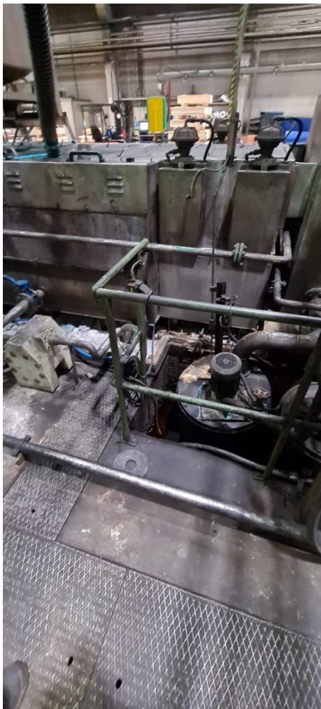
Kuva 13. Pesu- ja peittäuskoneen (1150) betoninen ylivuotoallas (Miika Rajala 2021).
