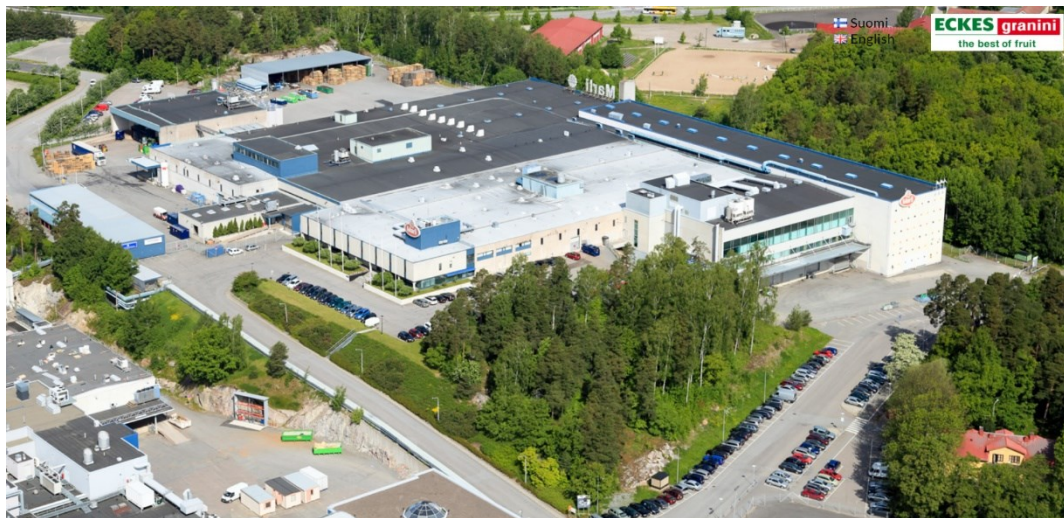
Kuva 1 Eckes-Granini Finland Oy Ab:n Turun tehdas Artukaisissa (Eckes-Granini Finland Oy Ab, 2018).
