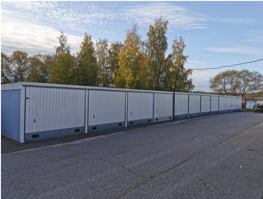
KUVA 16. Piha-alueella sijaitsee lämmittämättömiä varastotiloja, joissa säilytetään kajakkeja lokerohylyjärjestelmällä (22)
