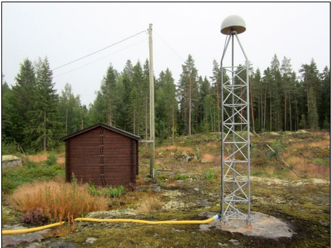
Kuva 3. FinnRef-asema VAA2:n antennimasto, antenni ja laitetilä [13].
