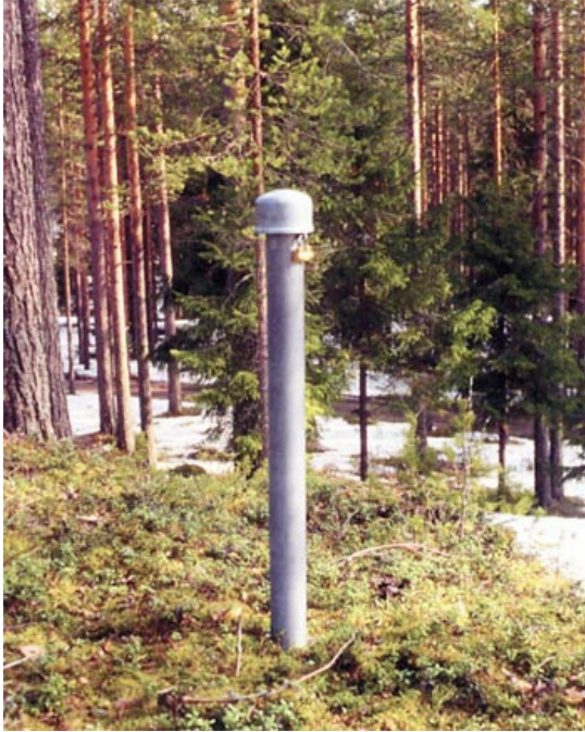
Kuva 1. Lukittu pohjavesiputki vandaali-osalla (ruostumaton teräs 150 x 1500 mm) (9).
