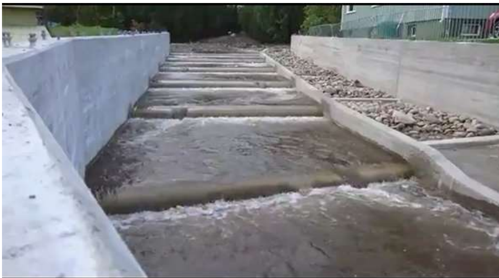
Kuva 3. Villamon uusi kalatie normaalin veden korkeuden aikana.
