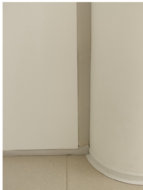
Kuva 15, Vaahtomuovilla tilkitty rako
