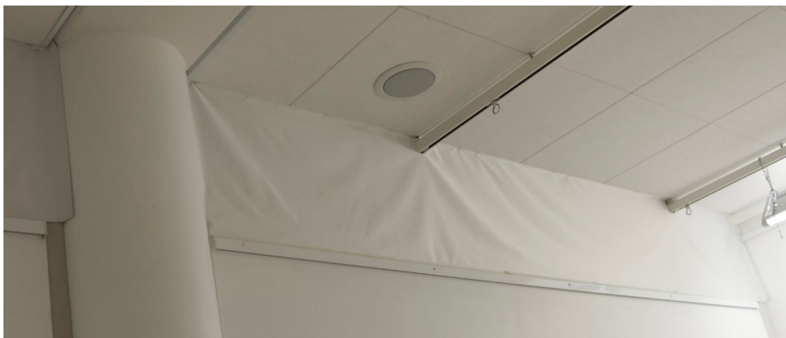
Kuva 13, Väliseinien yläpuolelle jäävä tila peitettynä pimentävällä kankaalla
