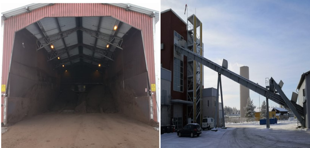
Kuva 5. ja 6. Honkajoen höyryvoimalaitoksen vastaanottoasema ja polttoaineen kuljettimet (kuvannut Ari Niemi).
