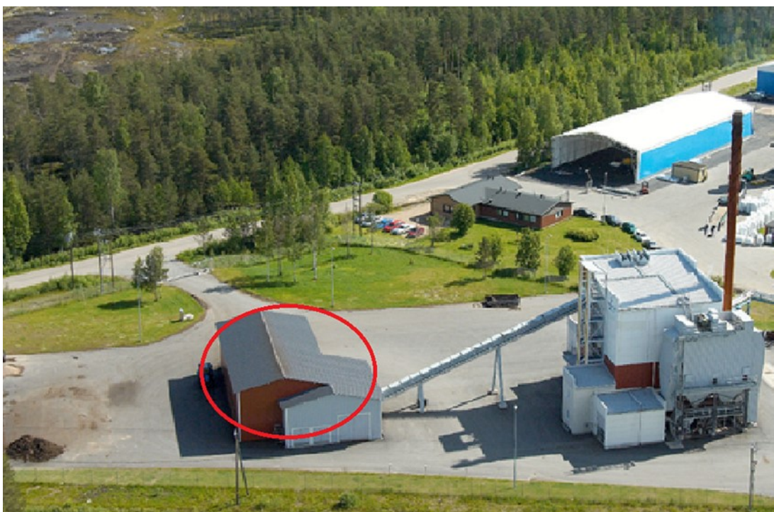
Kuva 4. Vatajankoski Oy:n Honkajoen höyryvoimalaitos. Punaisella on ympyröity alue missä tutkimukseen kohdistuvat laitteistot sijaitsevat. (Vatajankoski Oy)
