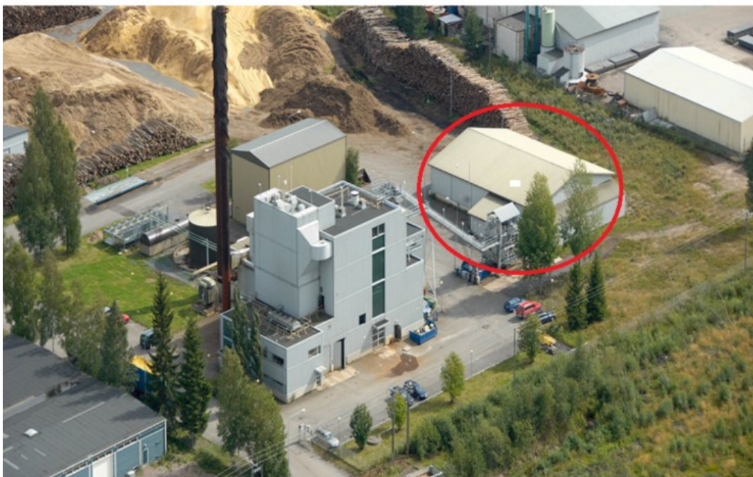
Kuva 1. Vatajankoski Oy:n lämmön -ja sähkön yhteistuotantolaitos. Kuvassa on punaisella ympyröity alue missä tutkimukseen kohdistuvat laitteistot sijaitsevat. (Vatajankoski Oy)
