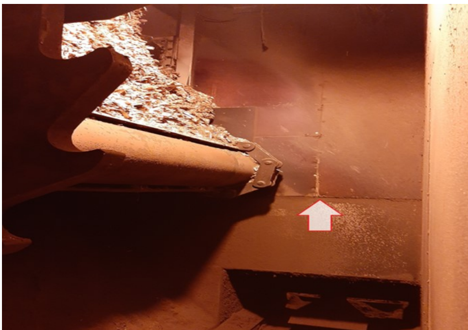
Kuva 21. Aseman pudotuskuilu, jossa mahdollinen ruuvien sijoituskohta (kuvannut Ari Niemi).
