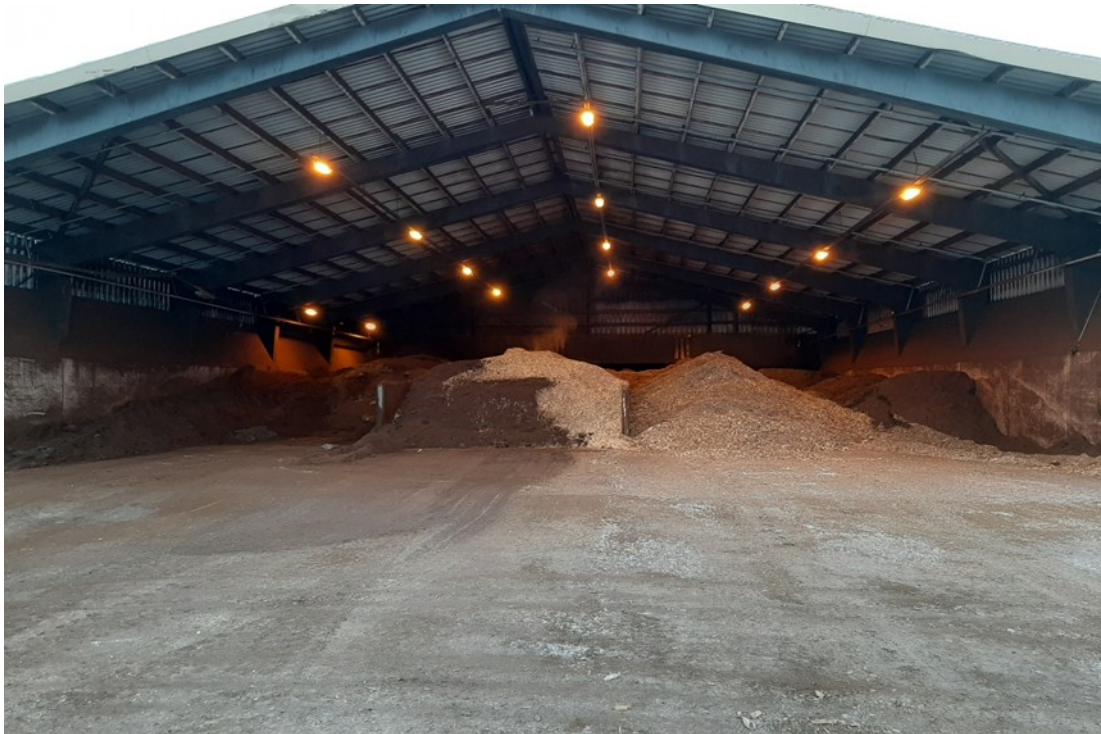
Kuva 2. Kankaanpään voimalaitoksen polttoaineen vastaanottoasema. Asemat on numeroitu 1-3 vasemmalta alkaen (kuvannut Ari Niemi).
