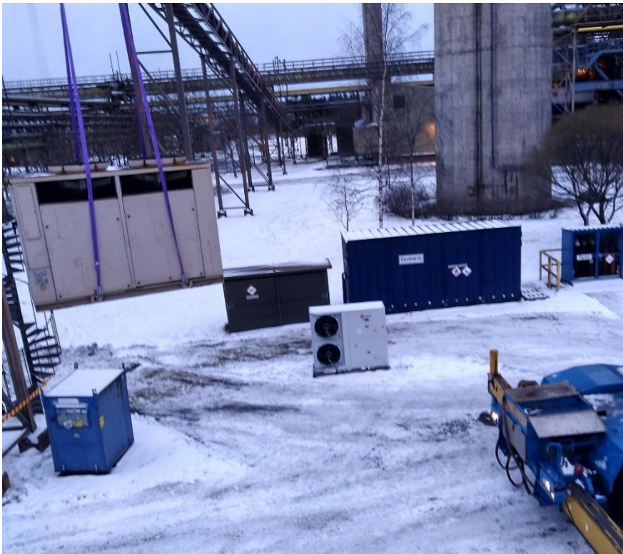
KUVA 18. Vanha koneikko nostetaan pois ja uusi valmiina nostoon.
