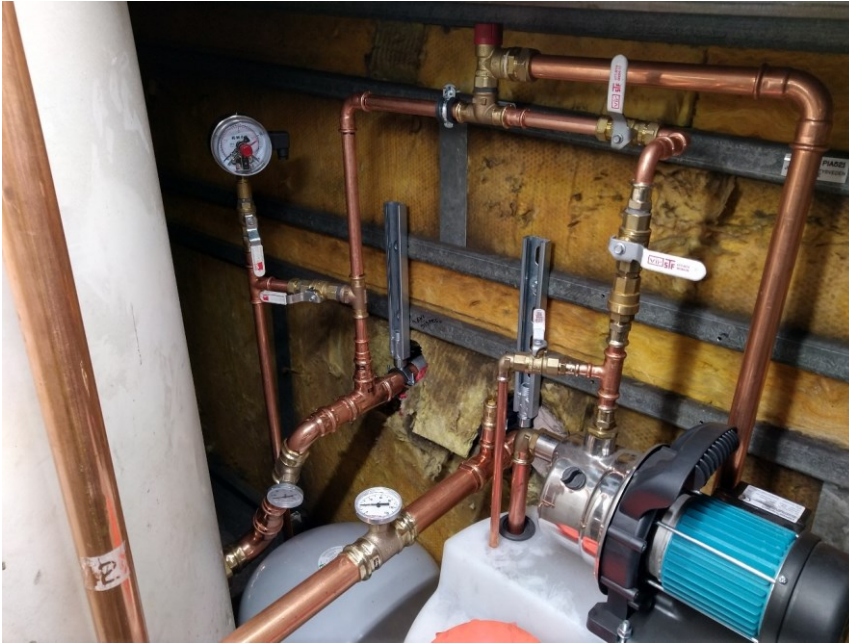
KUVA 21. Uusittua putkistoa ja putkistovaruksia ennen eristystä
