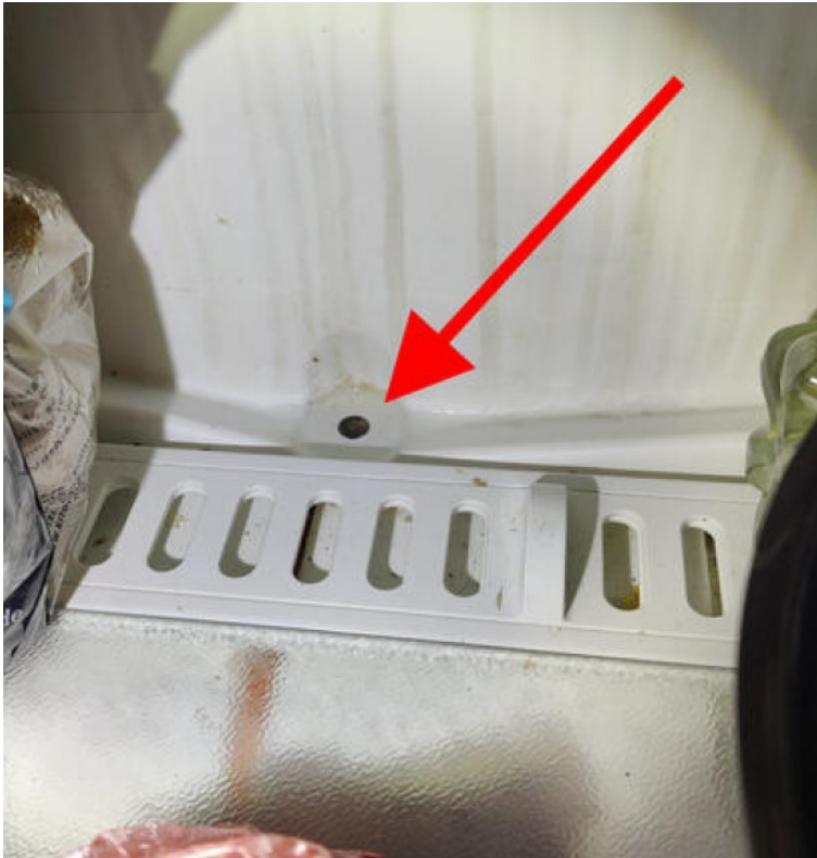
Kuva 23 Jääkaapin kondenssivesireikä (henkilökohtainen tiedonanto, Teppman Oy)
