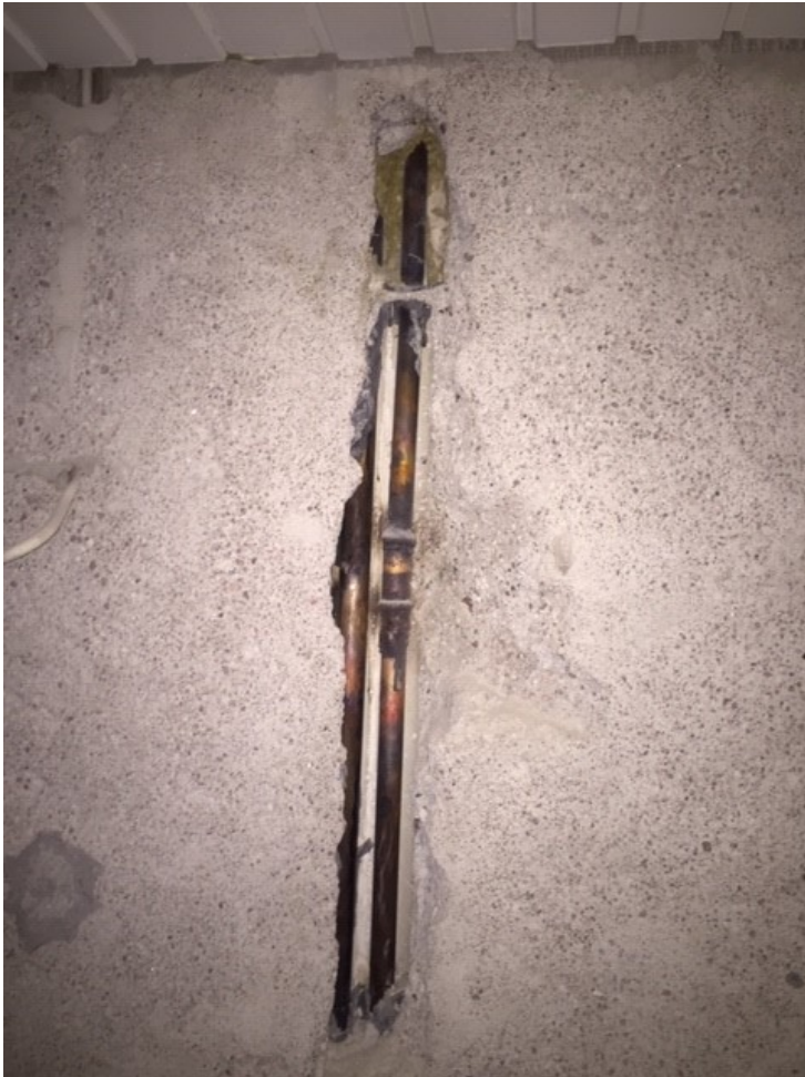
Kuva 32 Kylpyhuoneen seinän sisässä kulkeva käyttövesiputki (henkilökohtainen tiedonanto, Teppman Oy)
