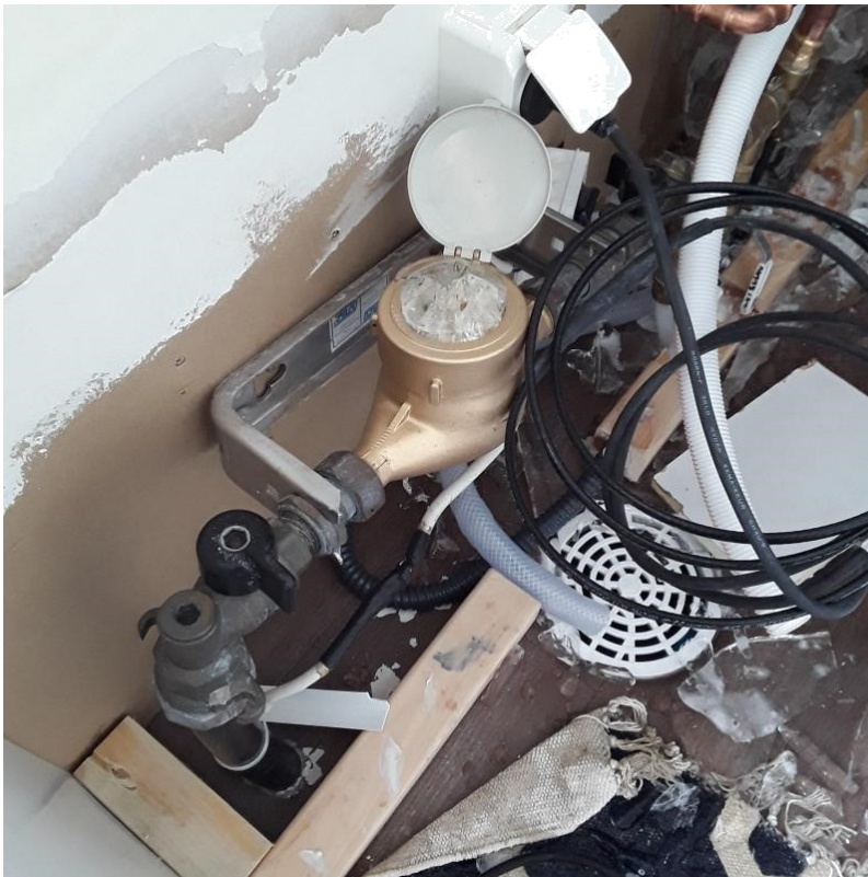
Kuva 10 Jäätynyt vesimittari (henkilökohtainen tiedonanto, Teppman Oy)
