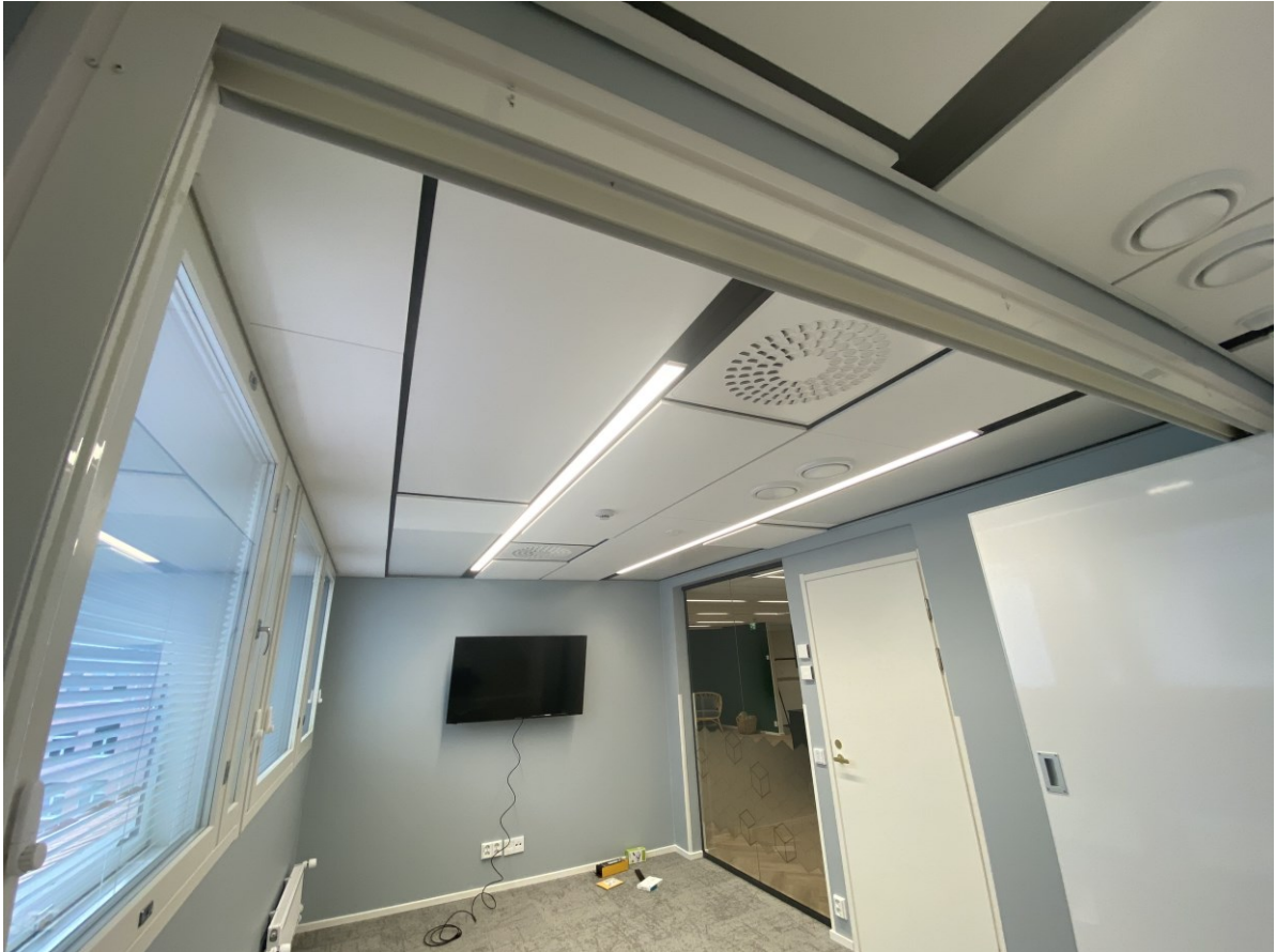
KUVA 3. Kattoon asennettuja lämmittäviä ja jäähdyttäviä ItuGraf-paneeleja
