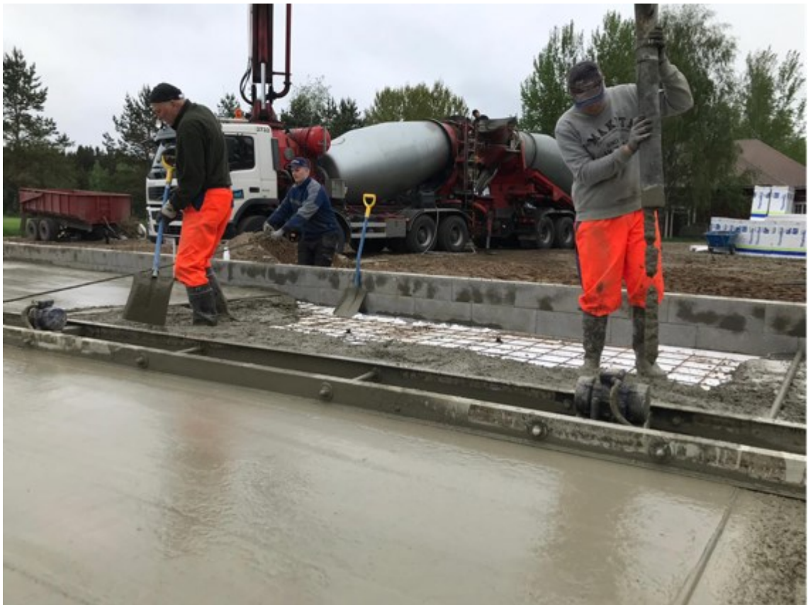
Kuva 8. Betonimassan levitystä kaksoistärypalkilla (Laakso 2019)
