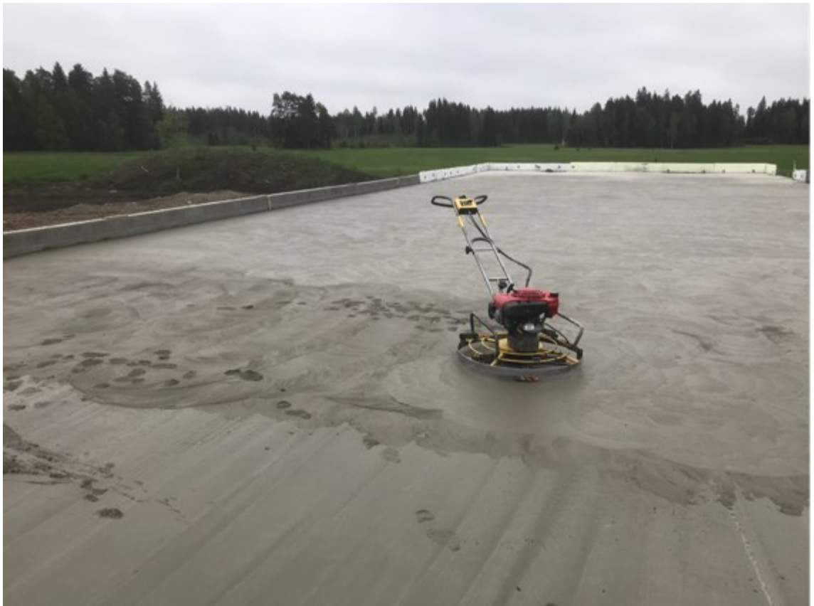
Kuva 9. Betonihierimellä hiertämistä (Laakso 2019)
