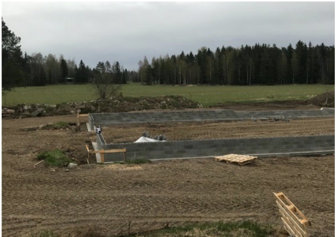
Kuva 5. Sokkelin valmistuminen (Laakso 2019)
