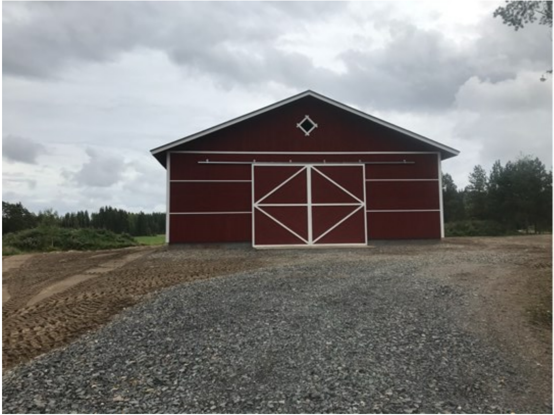
Kuva 16. Julkisivu länteen (Laakso 2020.)
