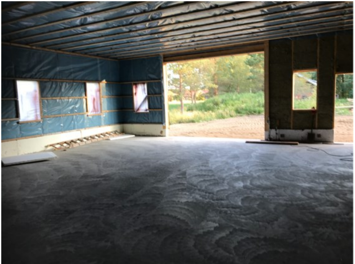
Kuva 13. Höyrynsulkumuovin ja koolauspuiden asennusta (Laakso 2020)
