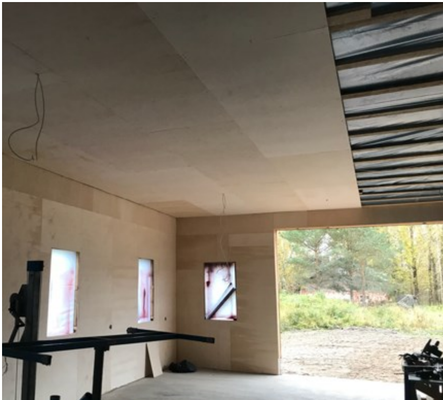
Kuva 14. Katon levytystä (Laakso 2020.)
