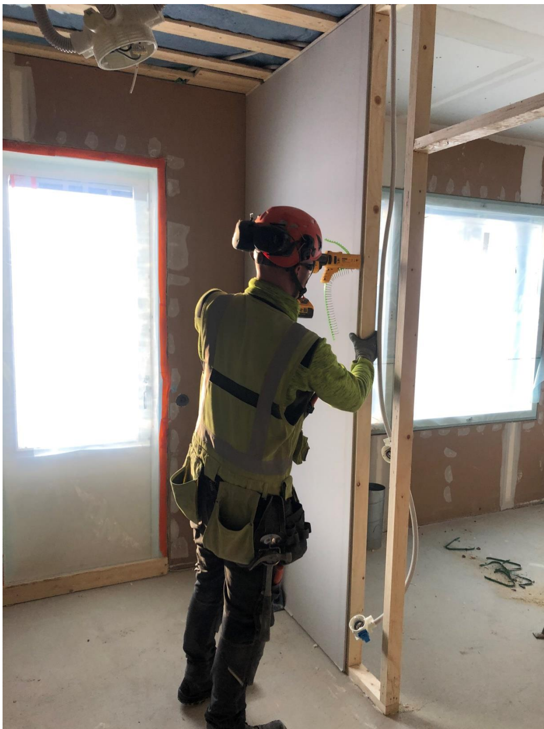
Kuva 6. Rankarakenteisen seinän valmistus kohteessa Asunto Oy Kuopion Pirtinkaari (Miettinen 2021, CC BY-SA)
