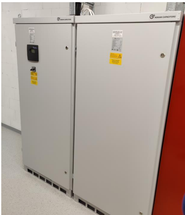
Kuva 11. PKJ2:n estokelaparisto KOMPJ2.
