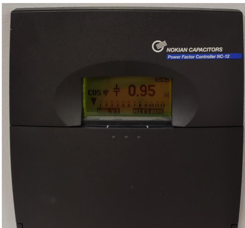
Kuva 13. Loistehonsäädin NC-12, perusnäky (KOMPJ1).
