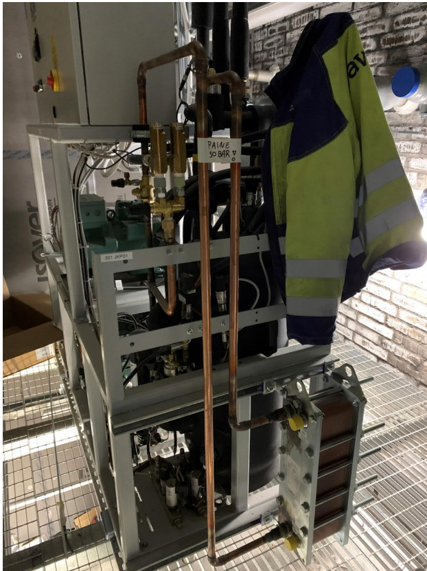
Kuva 3. CO 2 -käyttöön suunniteltu kuparinen levylämmönsiirrin.
