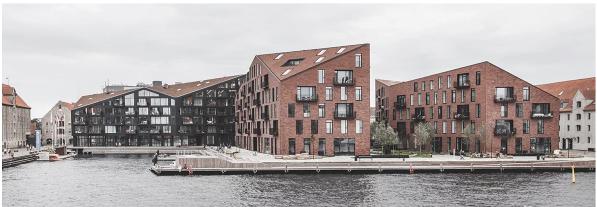
Kuva 27. Näkymä mereltä. ( https://inhabitat.com/worlds-first-nordic-eco-labelled-apartments-completed-in-copenhagen/ )
