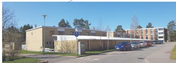
Rakennukset etelään (keltatiili) ja lounaaseen (punatiili), kuvattuna rakennuspaikan kaakkoiskulmasta.
