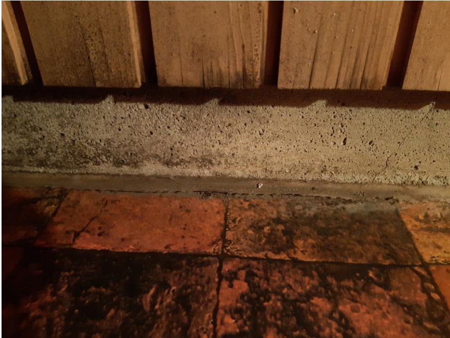
KUVA 17. Löylyhuoneen ja pukuhuoneen välisen seinän alaosa.
