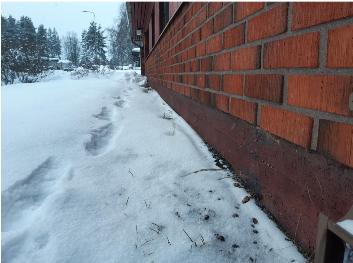
KUVA 9. Maanpinta seinän vierustalla on hyvin tasainen.
