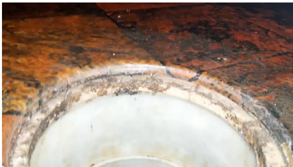
KUVA 14. Lattiamaton liitos lattiakaivoon.
