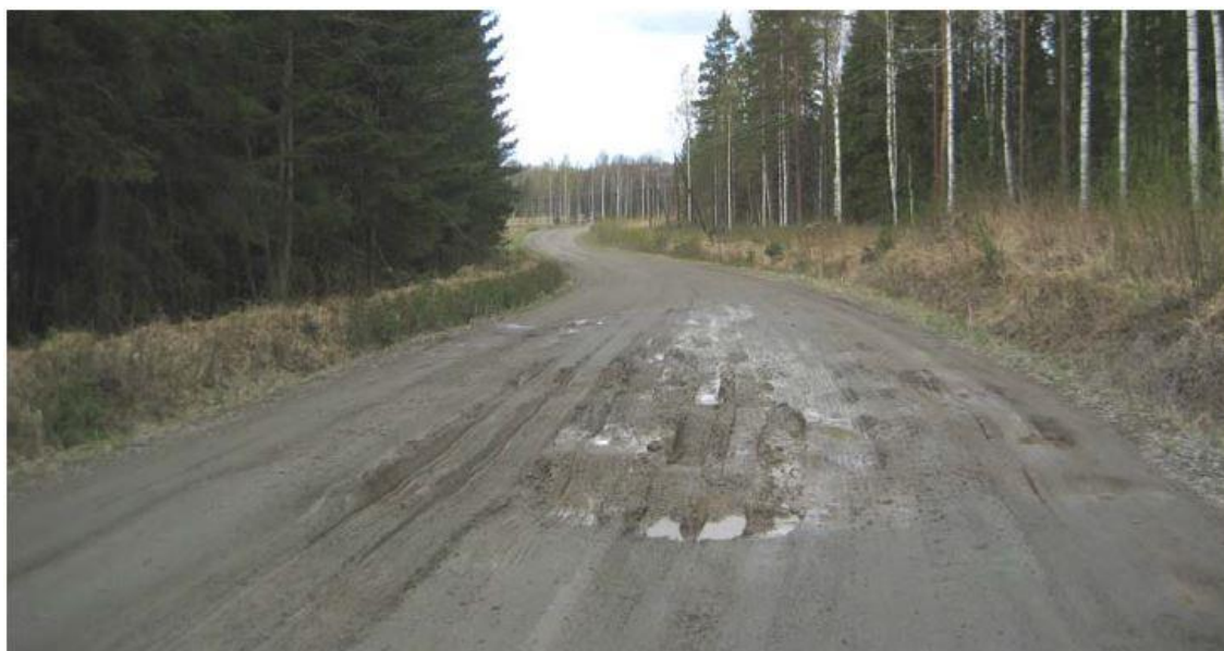
Kuva 4. Runkokelirikkoa. (Liikennevirasto, 2014).
