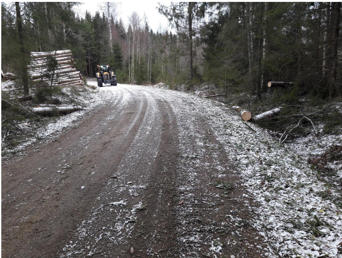
Tuulenskaadot katkaisevat liikennöinnin. Paalulla 2800.
