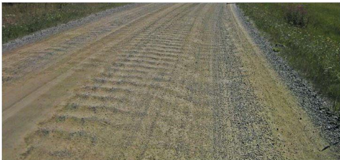
Kuva 5. Tien pinnan aaltoutumista eli ns. nimismiehenkiharaa. (Liikennevirasto, 2014).
