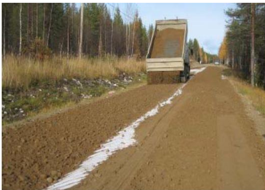
Kuva 8. Kantavuuden parantaminen suodatinkankaalla ja kantavalla murskeella. (Liikennevirasto, 2014).
