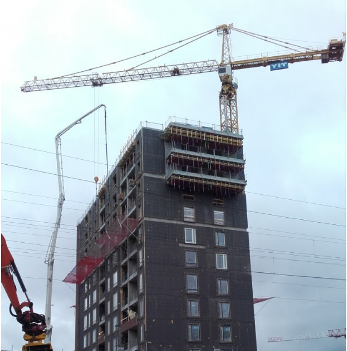
KUVA 90: Ulokeparvekkeet lähtevät vasta yläkerroksista
