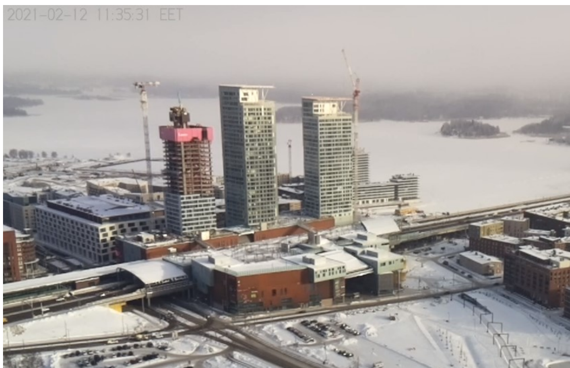
KUVA 1. Kuvakaappaus SRV:n Redin työmaakameran kuvasta 12.2.2021.
