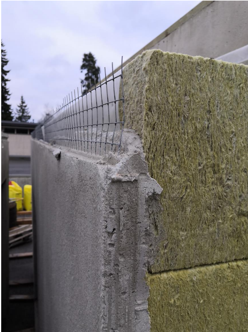
Kuva 3. Kolmikerrosrapatun elementin yläosa, jossa paljastettu verkko
