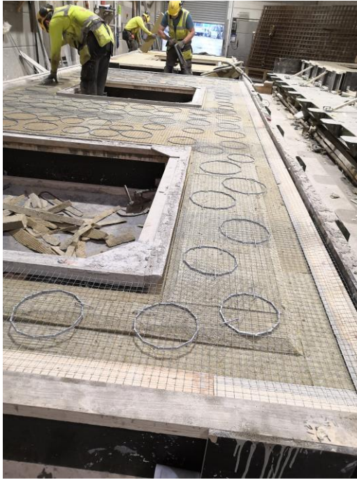
Kuva 5. Rappausverkon asentaminen käynnissä
