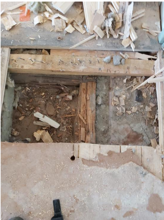
KUVA 7. Pönttöuunin viereinen alapohja-avaus (kuvan oikeassa reunassa pönttöuunin tiiliperustus ja n. 100 mm leveä kaista savea)
