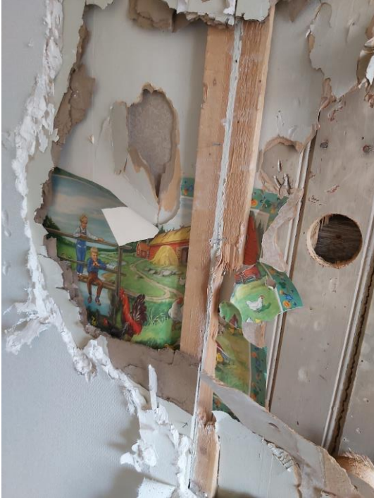
KUVA 14. Väliseinän pintarakenteet oli osittain purettu
