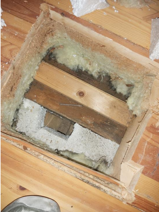
KUVA 9. Alapohja-avauksen eri rakennekerrokset
