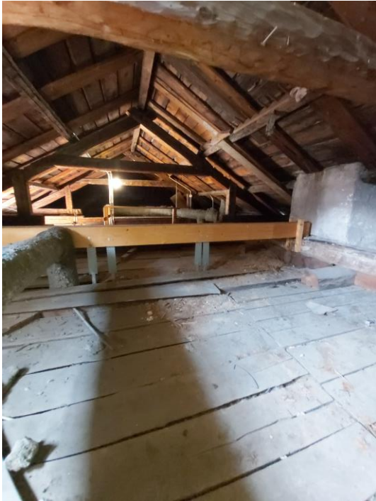
KUVA 16. Vanha palkki on ripustettu yläpohjaan lisättyyn liimapuupalkkiin
