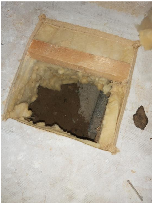
KUVA 8. Alapohja-avauksen eri rakennekerrokset
