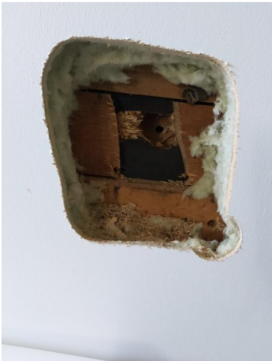
KUVA 13. Väliseinä on todennäköisesti vanha ulkoseinä
