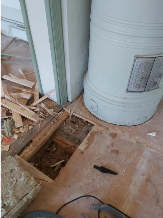
KUVA 6. Alapohja-avaus tehtiin lähelle pönttöuunia
