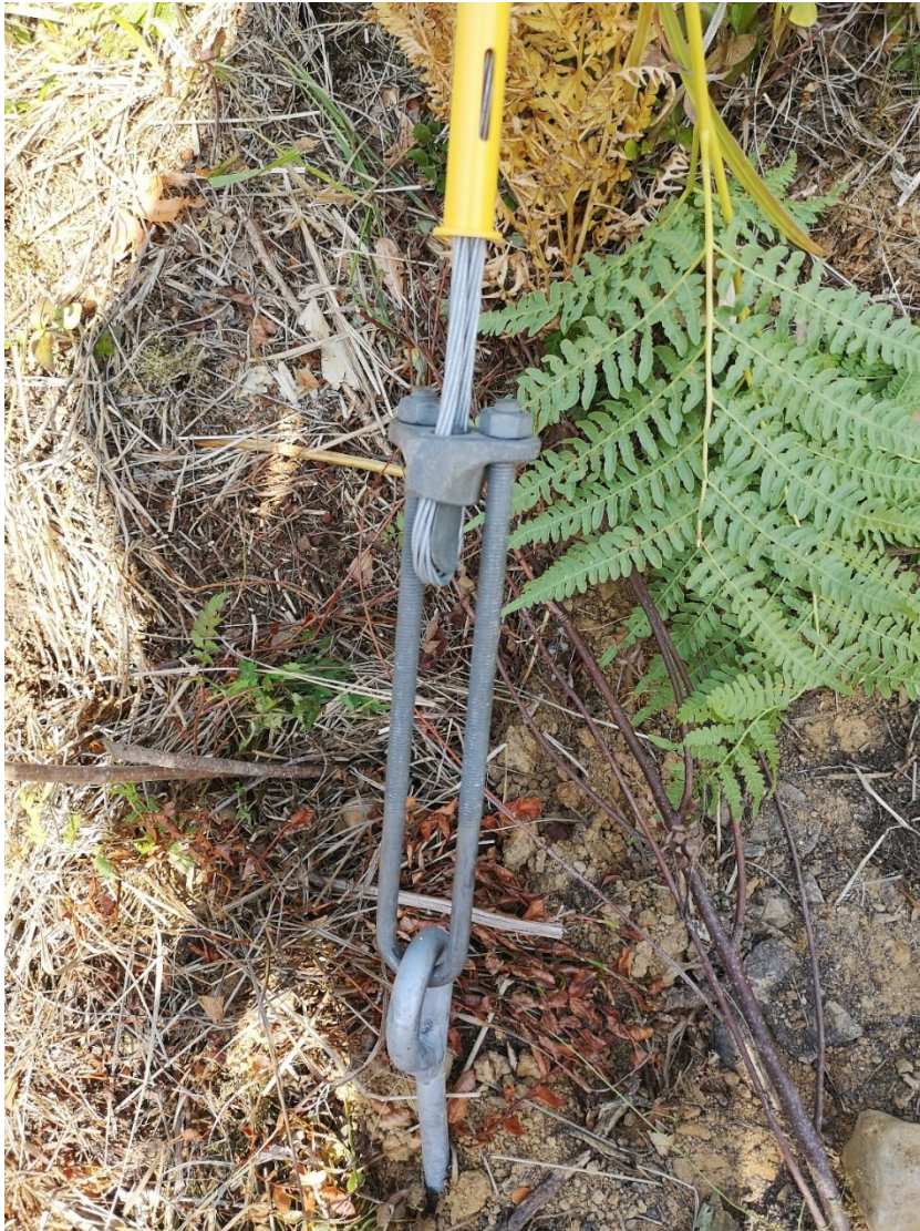
Kuva 11. Uuden pylvään haruksen alapää
