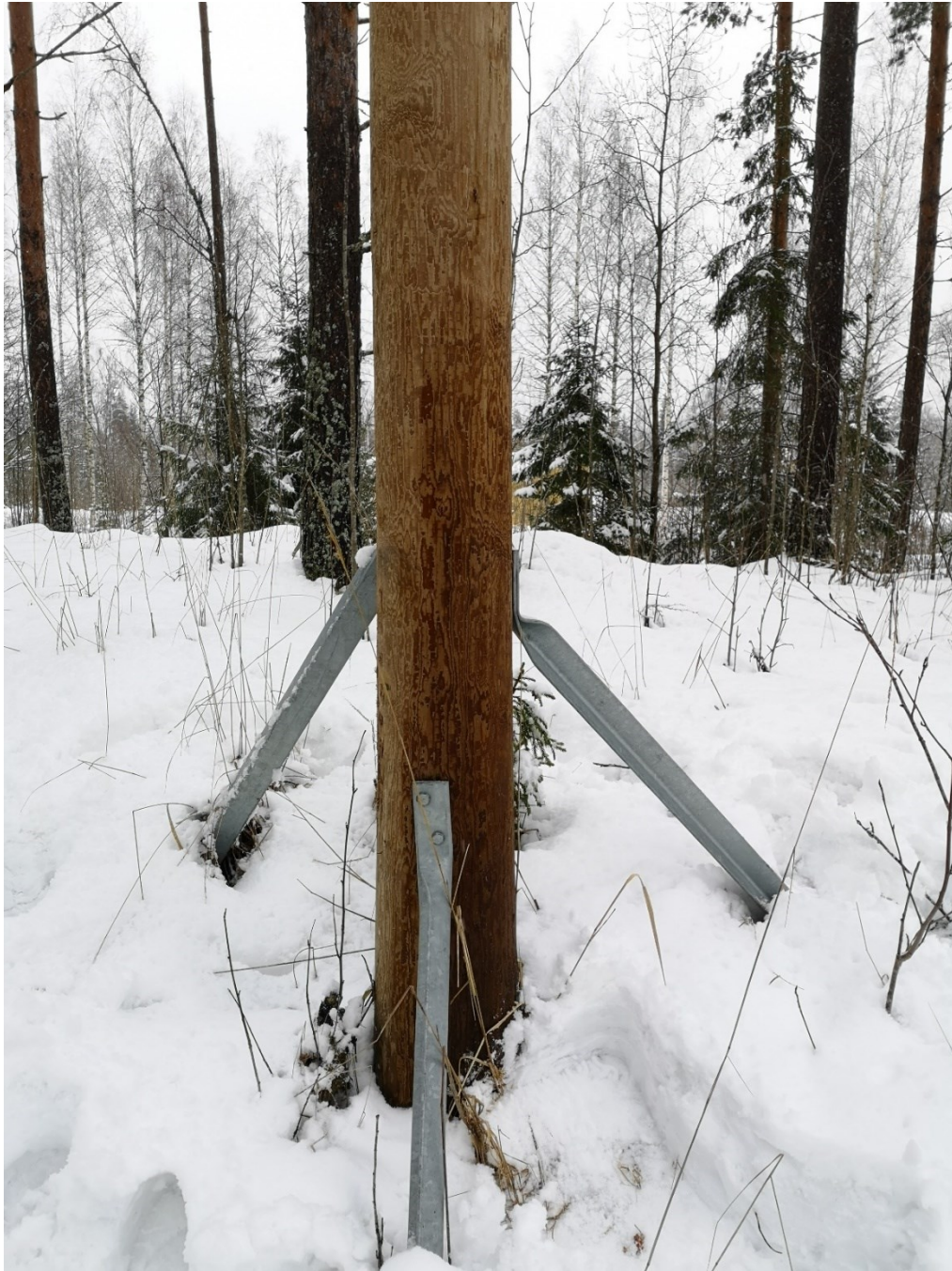
Kuva 10. Kalliolle asennettu pylväs
