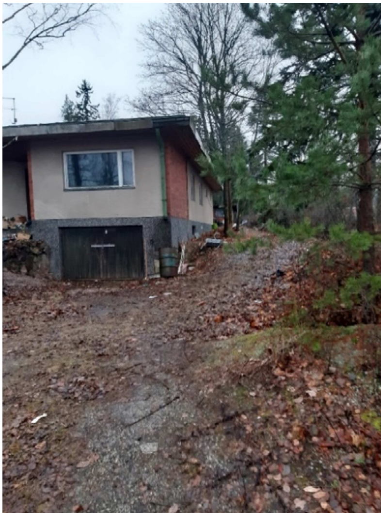
KUVA 9. Vanha ajoliittymä Muremelikujan ja Vuohirinteen kulmasta (Merikanto 2020)
