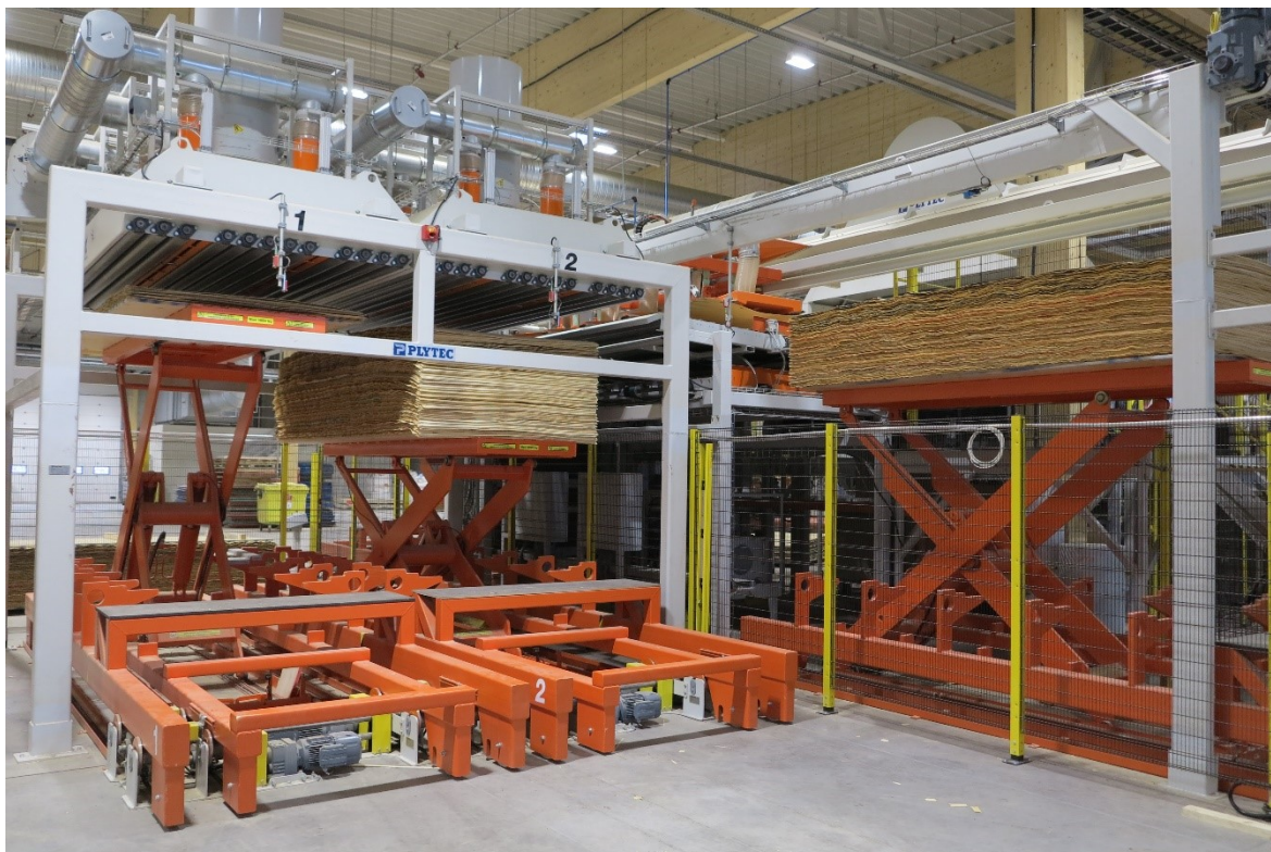
Kuva 3. Plytec Oy:n ladontalinja (Plytec 2021)
