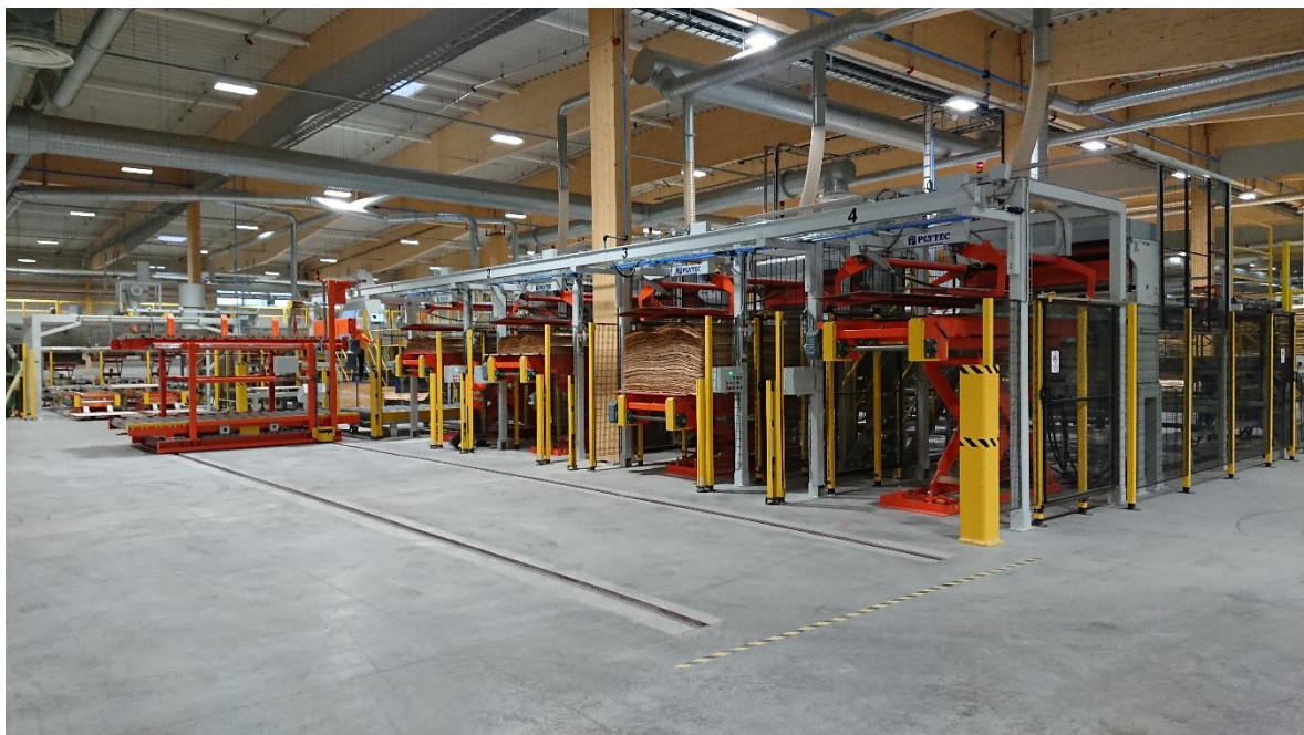
Kuva 4. B28 tolpan ympärille asennettu viulun jatkolinja (Plytec 2021)
