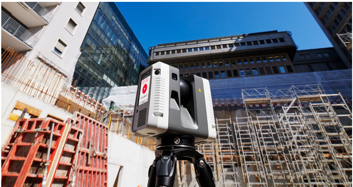
Kuva 13. Laserkeilain Leica RTC360 käytössä rakennustyömaalla. [43]
