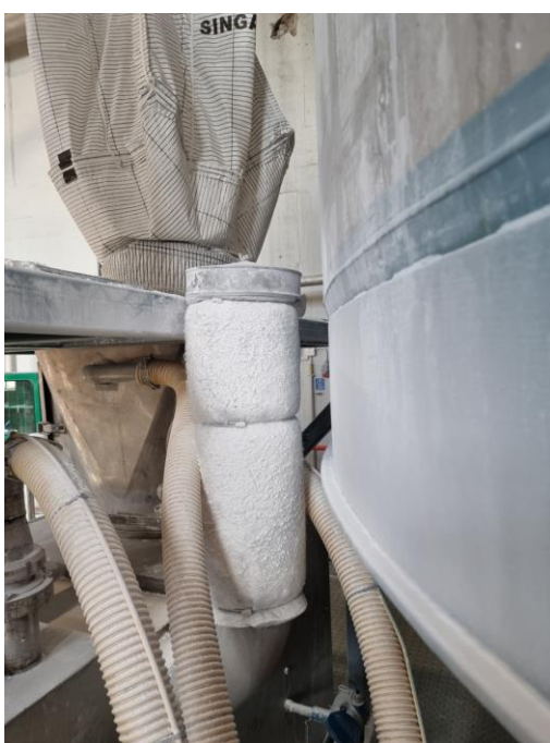
Kuva 11. Laitteen sisäisen ilmanpoiston suodatin sekä suodatinkangas.
